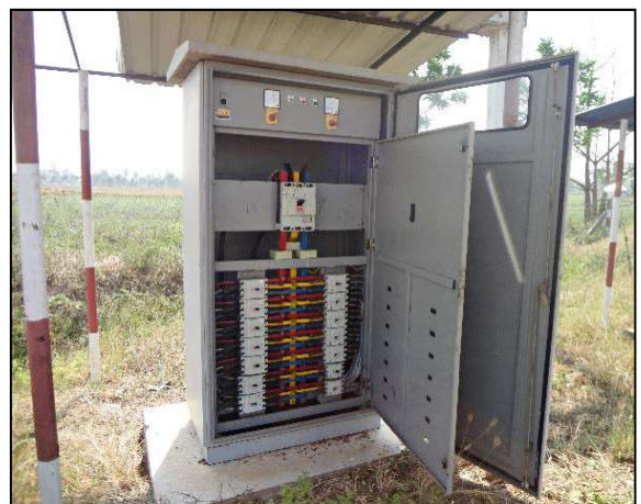
6) แผงจ่ายไฟฟ้า (Distribution Board)
