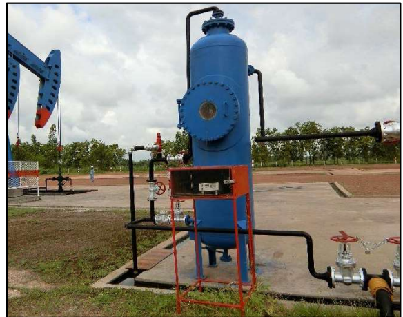
4) ถังวัดปริมาณ (Measuring Tank)
