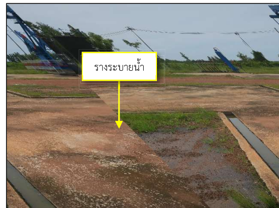
ภาพที่ 2.1-2 พื้นคอนกรีตและรางระบายน้ำล้อมรอบอุปกรณ์การผลิตปิโตรเลียม
