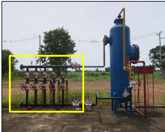
3) แผงวาล์วควบคุมการไหล (Valve Panel)
