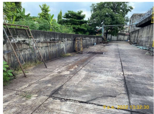
บ่อน้ำขนาด 2,000 ลิตรพร้อม Settling Cyclone (Longitudinal settling basin)
