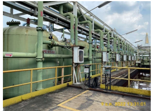
บ่อน้ำขนาด 2,000 ลิตรพร้อม Settling Cyclone (Longitudinal settling basin)
