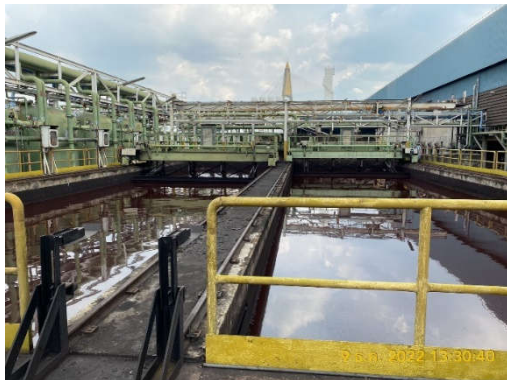
บ่อน้ำขนาด 2,000 ลิตรพร้อม Settling Cyclone (Longitudinal settling basin)
