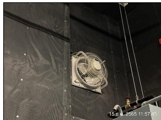
ภาพที่ 34 ติดตั้งพัดลมระบายอากาศภายในห้อง เครื่องกำเนิดไฟฟ้า
