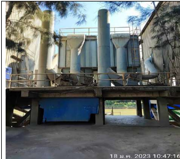
เครื่องดักฝุ่นแบบถุงกรอง (Bag Filter) จำนวน 2 ชุด (เป็นส่วนควบของท่าเทียบเรือที่ 1 และ 2)
