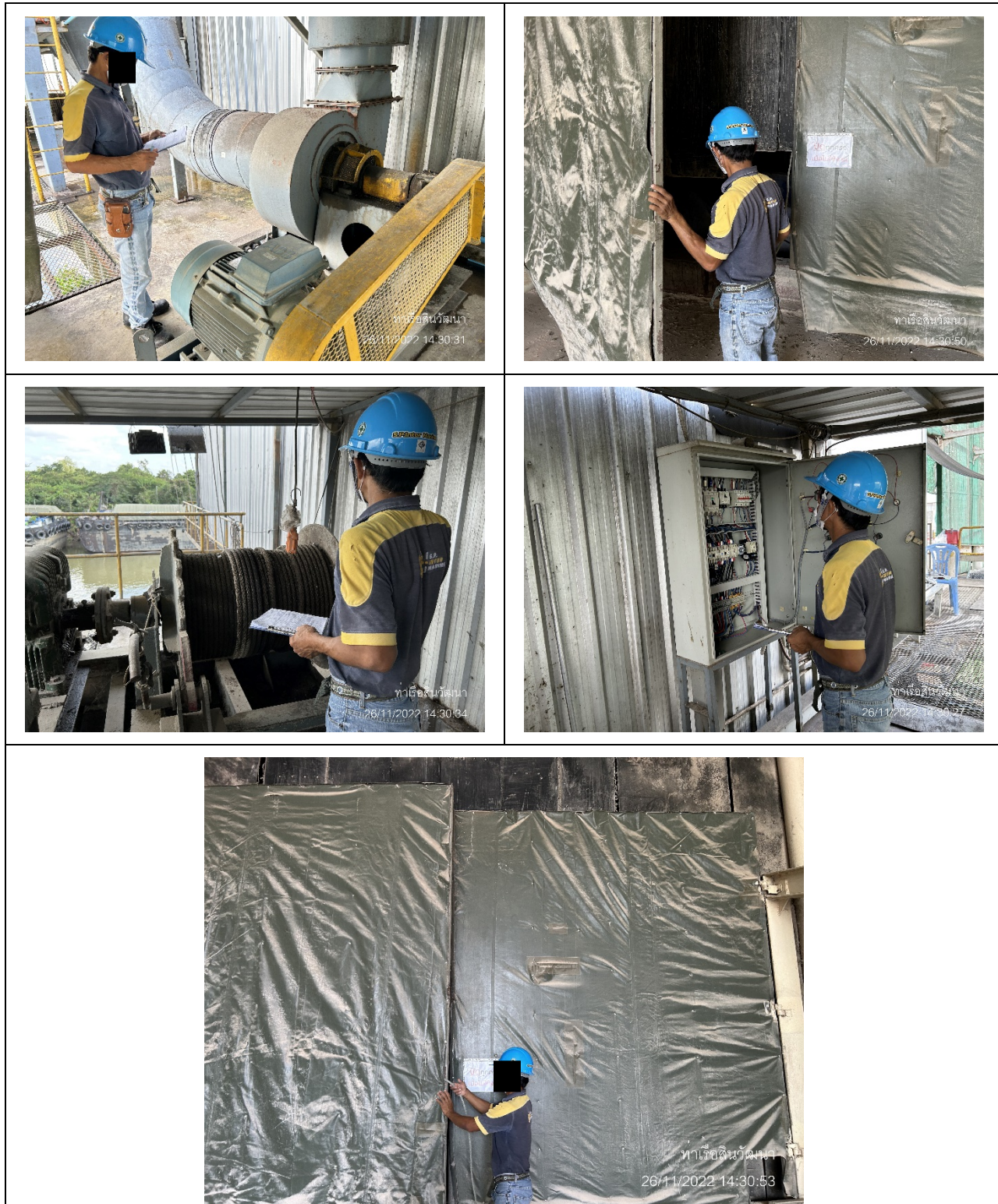
รูปที่ 2.2-12 การตรวจสอบสภาพเครื่องดักจับฝุ่น (Bag Filter) ก่อนลงสินค้าทุกครั้ง เพื่อให้ใช้งานได้ดีอยู่เสมอ
