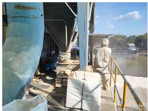
รูปที่ 2.2-13 การบำรุงรักษาในเชิงป้องกัน (Preventive Maintenance Program) ทุก 2,000 ชั่วโมงการทำงาน (ประมาณ 3 เดือน/ครั้ง) สำหรับเครื่องจักรหรืออุปกรณ์ที่เกี่ยวข้องกับการควบคุมมลพิษทางอากาศ โดยมีการเปลี่ยนถุงกรองเครื่องดักจับฝุ่น (Bag Filter) เมื่อวันที่ 12 พ.ย. 2565
