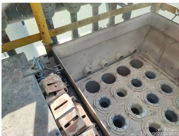
รูปที่ 2.2-13 การบำรุงรักษาในเชิงป้องกัน (Preventive Maintenance Program) ทุก 2,000 ชั่วโมงการทำงาน (ประมาณ 3 เดือน/ครั้ง) สำหรับเครื่องจักรหรืออุปกรณ์ที่เกี่ยวข้องกับการควบคุมมลพิษทางอากาศ โดยมีการเปลี่ยนถุงกรองเครื่องดักจับฝุ่น (Bag Filter) เมื่อวันที่ 12 พ.ย. 2565
