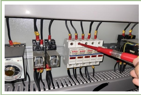
รูปภาพที่ 1.11 ตรวจสอบเซอร์กิตเบรกเกอร์
