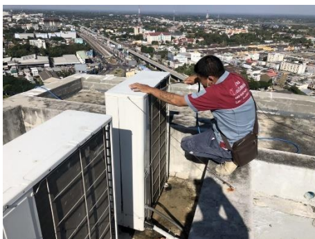
รูปที่ 2.1-37 การอนุรักษ์พลังงาน (ล้างเครื่องปรับอากาศ)
