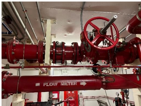
รูปที่ 2.1-39 ระบบป้องกันอัคคีภัย (ระบบท่อเย็น)
