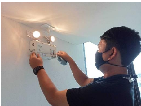
รูปที่ 2.1-43 การบำรุงรักษาระบบป้องกันอัคคีภัย (ตรวจสอบไฟฉุกเฉิน)
