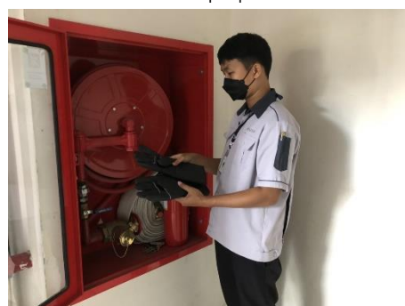
รูปที่ 2.1-39 ระบบป้องกันอัคคีภัย (ตู้ FHC และป้ายแสดงวิธีใช้อุปกรณ์ดับเพลิง)
