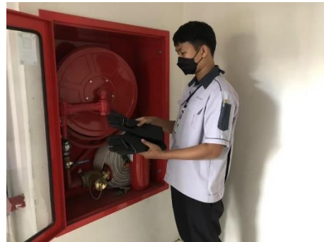
รูปที่ 2.1-43 การบำรุงรักษาระบบป้องกันอัคคีภัย (ตรวจสอบสายยางดับเพลิง)
