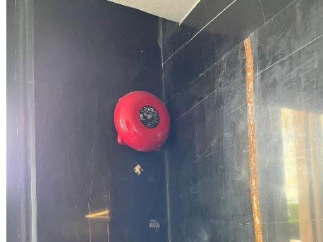
รูปที่ 2.1-39 ระบบป้องกันอัคคีภัย (กริ่งส่งสัญญาณเตือนภัย)
