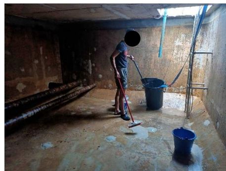
รูปที่ 2.1-13 การล้างถังเก็บน้ำโครงการ
