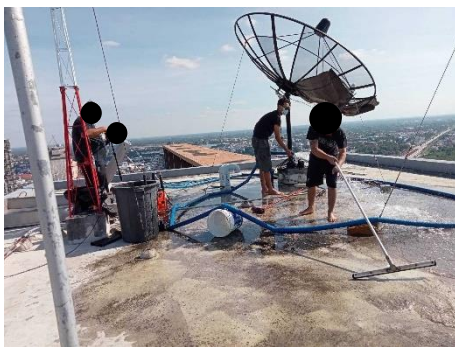
รูปที่ 2.1-13 การล้างถังเก็บน้ำโครงการ
