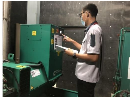
รูปที่ 2.1-43 การบำรุงรักษาระบบป้องกันอัคคีภัย (ตรวจสอบ Generator)
