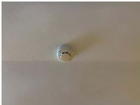
รูปที่ 2.1-39 ระบบป้องกันอัคคีภัย (เครื่องตรวจจับควัน)
