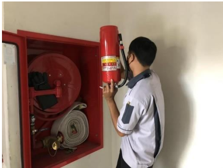
รูปที่ 2.1-43 การบำรุงรักษาระบบป้องกันอัคคีภัย (ตรวจสอบถังเคมีดับเพลิง)
