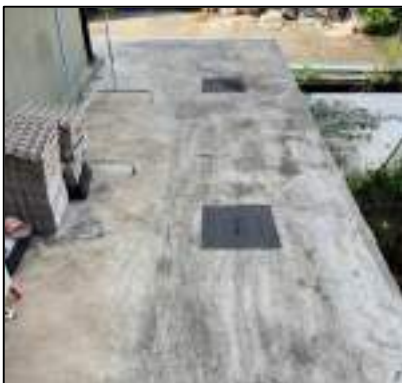
รูปที่ 83 ถังตกไขมันรับน้ำเสียจากโรงอาหาร
