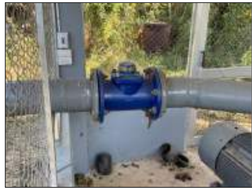
รูปที่ 87 มาตรวัดน้ำบริเวณสถานีสูบน้ำ
