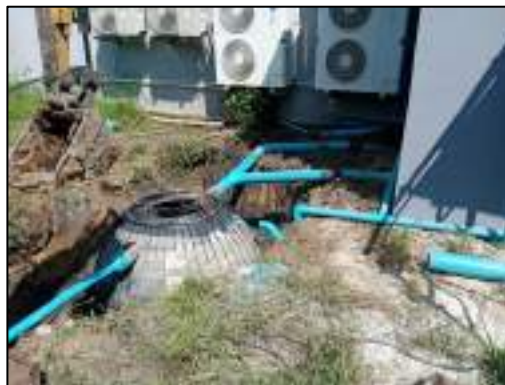
รูปที่ 24 ถังบำบัดน้ำเสียสำเร็จรูปแบบกระโถน-กรองไร้อากาศรองรับน้ำเสียจากบ้านพักนอกและอาคารเครื่องจักรกลการเกษตร
