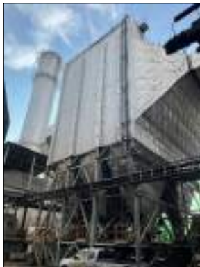
รูปที่ 78 หม้อไอน้ำติดตั้งระบบดักฝุ่นแบบไฟฟ้าสถิต ต่ออนุกรมจากระบบมัลติไซโคลน
