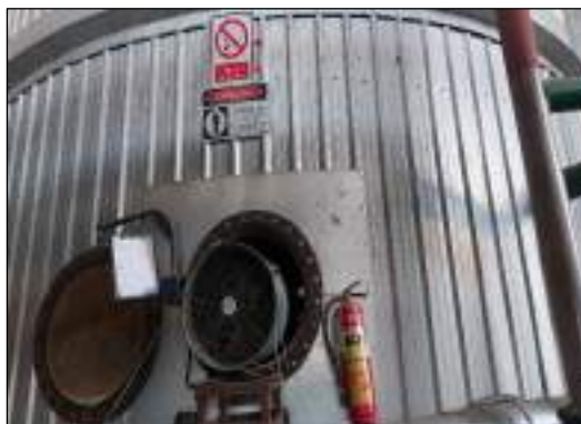
รูปที่ 70 การเปิดพื้นที่อับอากาศและใช้พัดลมเป่าระบายอากาศ
