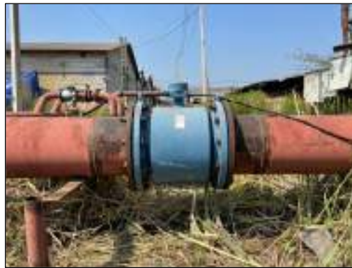
รูปที่ 20 มิเตอร์ตรวจสอบปริมาณน้ำเสีย
