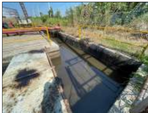
รูปที่ 22 บ่อดักน้ำมัน
