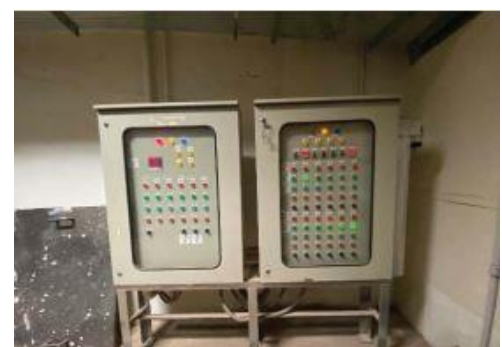
ตู้ควบคุมการทำงานระบบบำบัดน้ำเสีย
