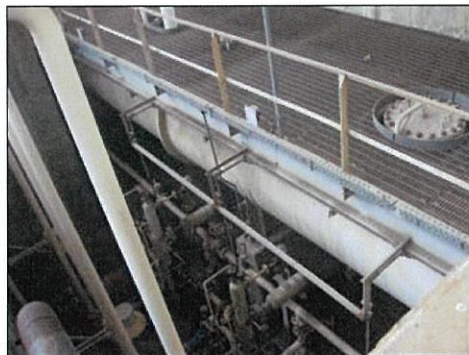
ภาพที่ 2.2-10 ถังแยกไฮโดรคาร์บอนที่ปนเปื้อนในน้ำ (AD-498)
