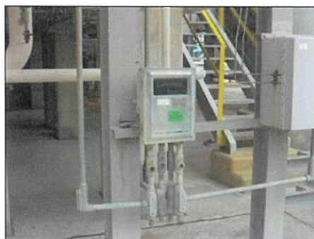
ภาพที่ 2.2-2 On-line O 2 Analyzer ของปล่อง Furnace
