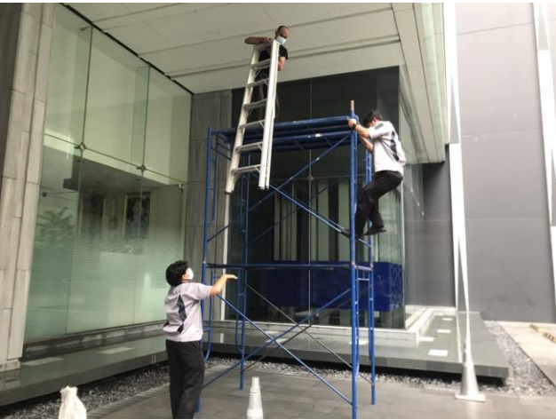
ช่างอาคารติดตั้งฝาครอบไฟ LED แทนที่หลอดชำรุด บริเวณด้านหน้าอาคารพักอาศัย
