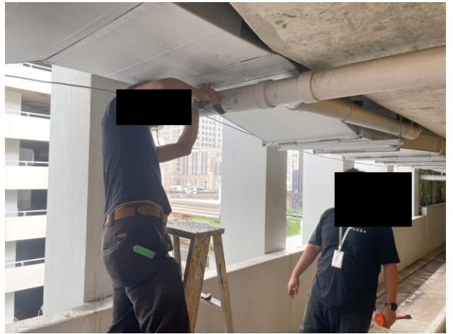
ช่างอาคารแก้ไขท่อระบายน้ำอุดตันจากเศษปูนบริเวณ ชั้น 9 อาคารลานจอดรถ
