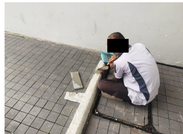
ช่างอาคารซ่อมแซมหมอนคอนกรีตกันล้อรถที่ชำรุดให้มีสภาพที่พร้อมใช้งาน
