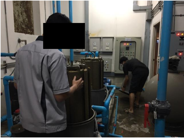
ช่างอาคารล้างทำความสะอาดไส้กรองสรวายน้ำกรองและบ่อพอลอย่างสม่ำเสมอทุกสัปดาห์
