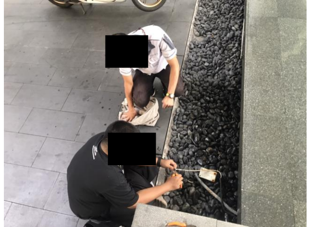
ช่างอาคารทำการเปลี่ยนหลอดไฟ LED เส้น บริเวณบ่อพอล 2
