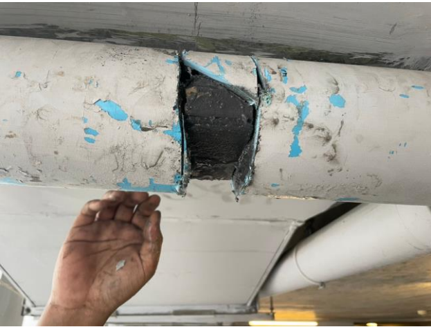
ช่างอาคารแก้ไขท่อระบายน้ำอุดตันจากเศษปูนบริเวณ ชั้น 9 อาคารลานจอดรถ
