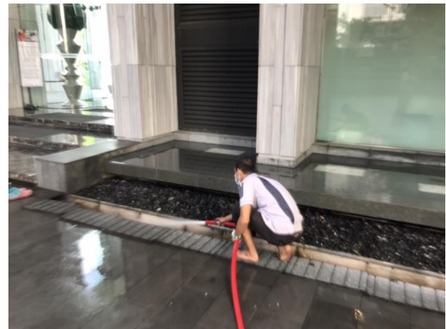
ช่างอาคารขัดล้างทำความสะอาดท่อและนำไปไม้หรือสิ่งทีอาจทำให้ท่ออุดตันออกบริเวณหน้าโครงการ
