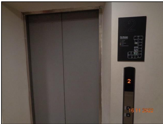
รูปที่ 2-35 ลิฟต์ดับเพลิง
