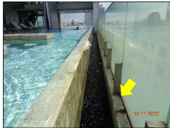
รูปที่ 2-57 รางระบายน้ำล้นสระว่ายน้ำ
