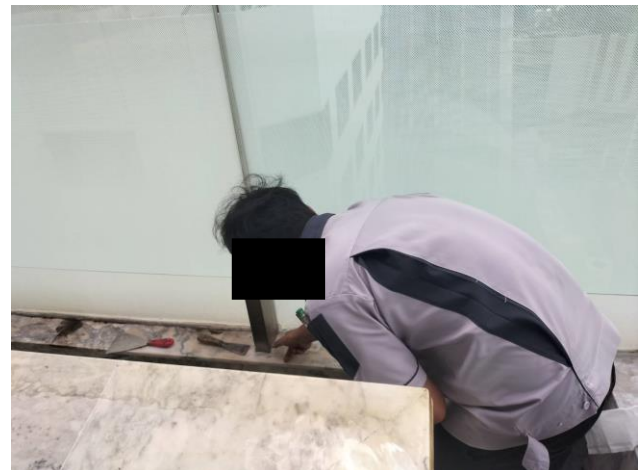
ช่างอาคารยิงซิลิโคนขอบกระจกแทนของเดิมที่หลุดร่อน บริเวณรอบสระว่ายน้ำ ชั้น 27
