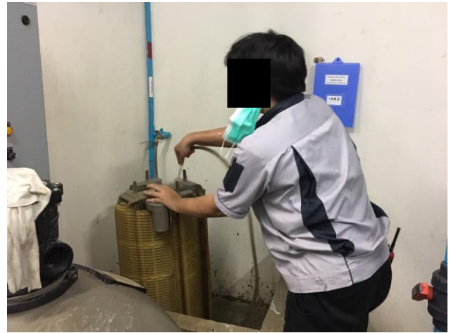
ช่างอาคารล้างทำความสะอาดไส้กรองสระว้ยน้ำกรองและบ่อพอลอย่างสม่ำเสมอทุกสัปดาห์
