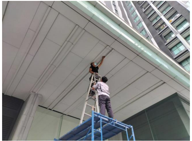
ช่างอาคารติดตั้งฝาครอบไฟ LED แทนที่หลอดชำรุด บริเวณด้านหน้าอาคารพักอาศัย
