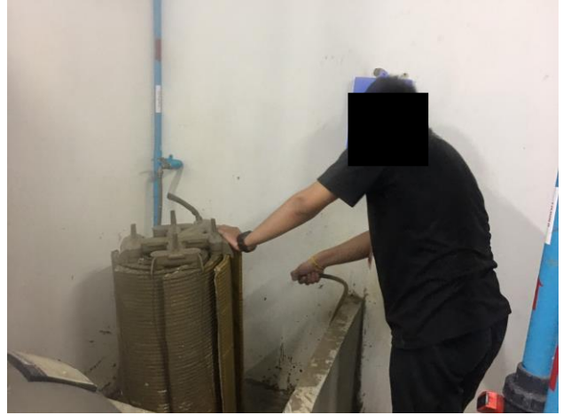
ช่างอาคารล้างทำความสะอาดไส้กรองสรวายน้ำกรองและบ่อพอลอย่างสม่ำเสมอทุกสัปดาห์
