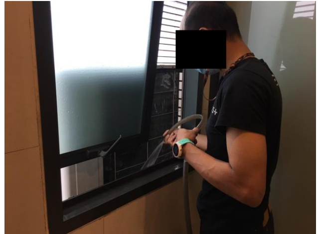
ช่างอาคารล้างทำความสะอาดคอยล์ร้อน พัดลมคอยล์เย็นและล้างถาดน้ำทิ้งของเครื่องปรับอากาศบริเวณ ห้องออกกำลังกาย พื้นที่ส่วนกลาง ชั้น 27
