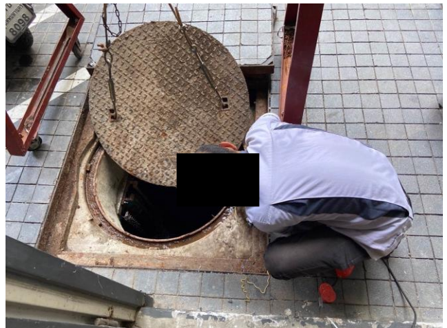
ช่างอาคารทำการเปลี่ยนลูกลอยบ่อบำบัด บั้ม SWP5-6
