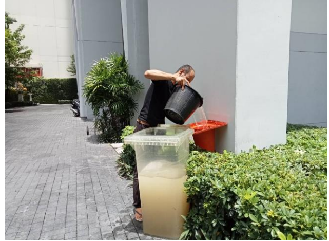
ช่างอาคารเติมหัวเชื้อจุลินทรีย์และฉีดน้ำเพื่อปรับสภาพน้ำในบ่อบำบัดน้ำเสียภายในโครงการ
