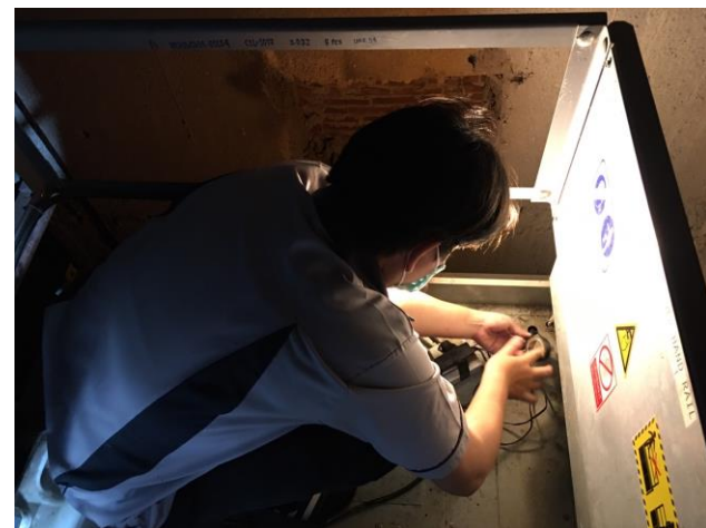
ช่างอาคารแก้ไขกล่องวงจรปิดลิฟต์ตัวที่ 5 บริเวณอาคารลานจอดรถที่ดับให้กลับมาใช้งานได้ตามปกติ
