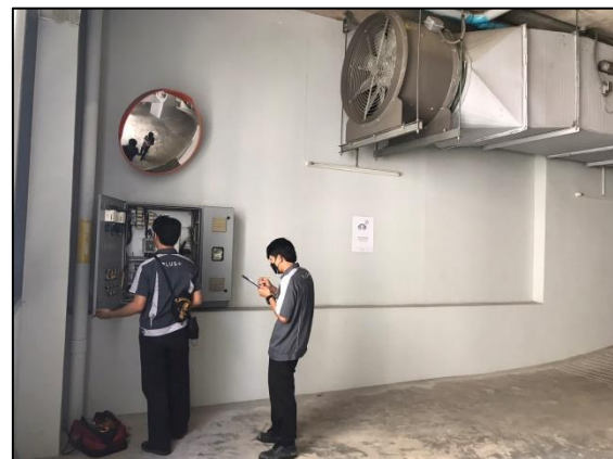
รูปที่ 2-39 การตรวจสอบการทำงานของระบบระบายอากาศ
