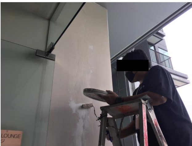
ช่างอาคารซ่อมแซมและแก้ไขผนังอาคารที่สีหลุดร่อนบริเวณพื้นที่ส่วนกลาง ชั้น 27
