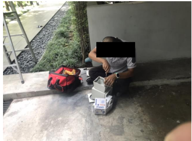
ช่างอาคารทำการเปลี่ยนคอมไฟขาวบริเวณหน้าอาคาร B
