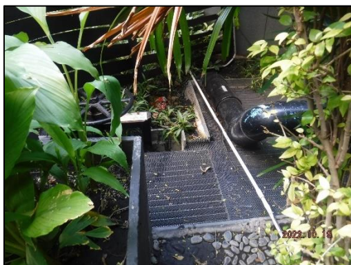
บ่อฟักน้ำสุดท้ายของระบบระบายน้ำของโครงการก่อนระบายลงสู่ระบบระบายน้ำบริเวณด้านหน้าโครงการ วันที่ 19 ตุลาคม พ.ศ. 2565
