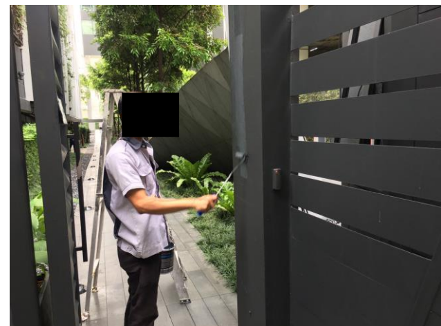
ช่างอาคารขัดและทาสีประตูเหล็กที่สีหลุดร่อนให้กลับมามีสภาพพร้อมใช้งานบริเวณด้านหน้าโครงการ
