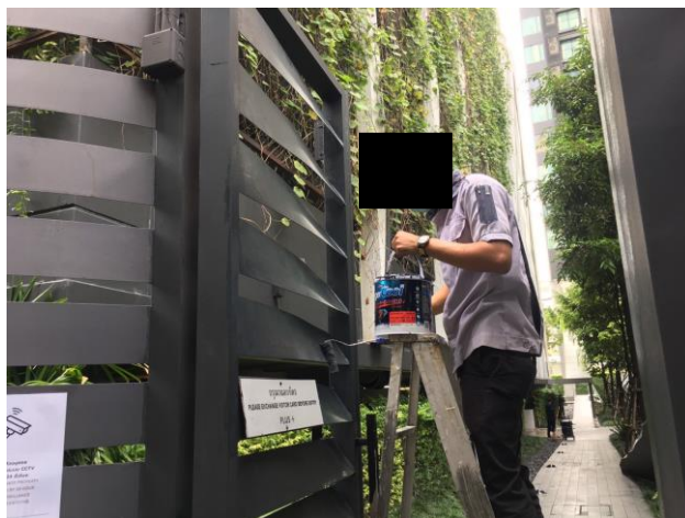
ช่างอาคารขัดและทาสีประตูเหล็กที่สีหลุดร่อนให้กลับมามีสภาพพร้อมใช้งานบริเวณด้านหน้าโครงการ
