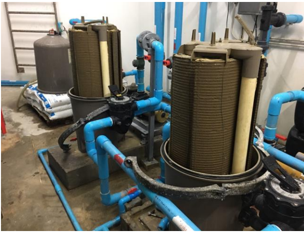
ช่างอาคารล้างทำความสะอาดไส้กรองสรว่ายน้ำกรองและบ่อพอลอย่างสม่ำเสมอทุกสัปดาห์
