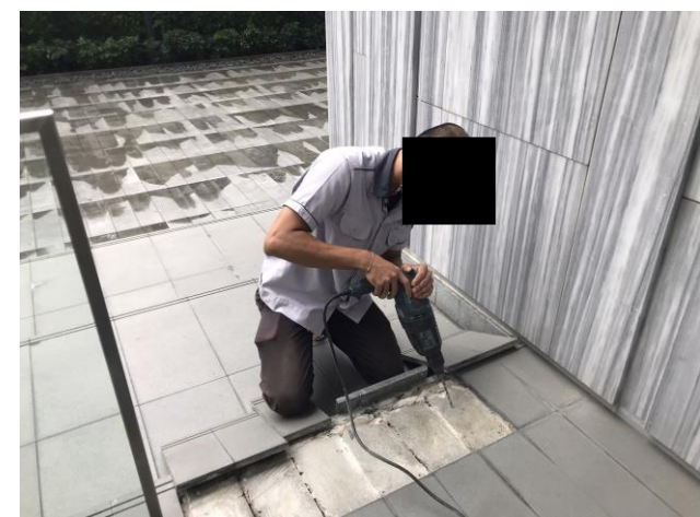
ช่างอาคารเปลี่ยนแผ่นหินแทนแผ่นเดิมที่แตกร้าวเสื่อมสภาพบริเวณบันไดทางเดินด้านหน้าลิบบี้
