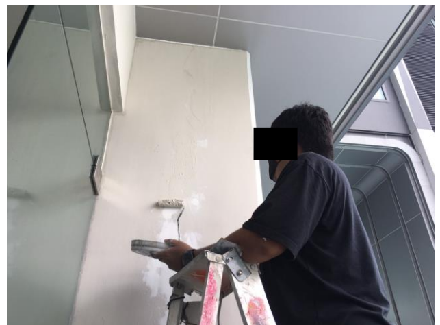
ช่างอาคารซ่อมแซมและแก้ไขผนังอาคารที่สีหลุดร่อนบริเวณพื้นที่ส่วนกลาง ชั้น 27
