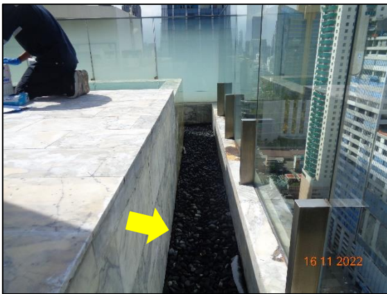
รูปที่ 2-57 รางระบายน้ำล้นสระว่ายน้ำ
