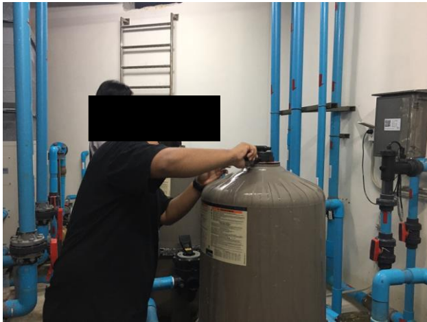
ทำการเปลี่ยน pressure gauge ถังกรองสรวายน้ำตามทีม PM ส่วนกลางแจ้ง
