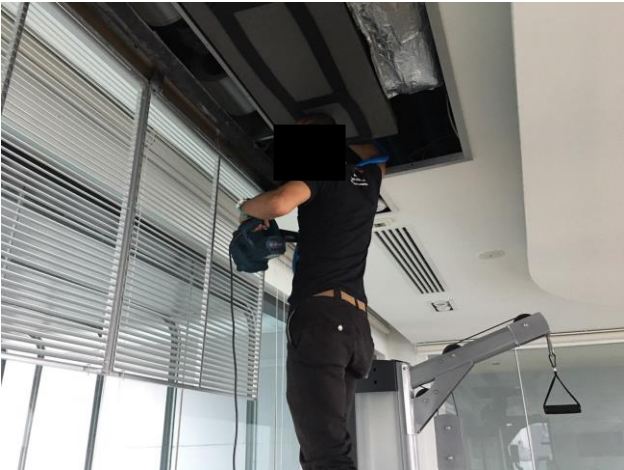
ช่างอาคารล้างทำความสะอาดคอยล์ร้อน พัดลมคอยล์เย็นและล้างถาดน้ำทิ้งของเครื่องปรับอากาศบริเวณ ห้องออกกำลังกาย พื้นที่ส่วนกลาง ชั้น 27
