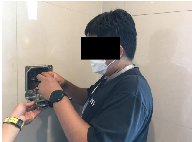
ช่างอาคารซ่อมแซมปุ่มกดน้ำโถสุขภัณฑ์ชายบริเวณพื้นที่ส่วนกลางชั้น 27 ให้กลับมาใช้งานได้ตามปกติ
