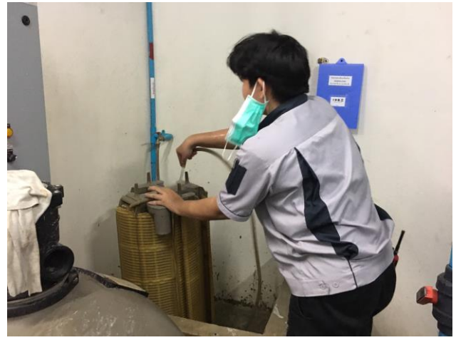
ช่างอาคารล้างทำความสะอาดไส้กรองสระว่ายน้ำกรองและบ่อพอลอย่างสม่ำเสมอทุกสัปดาห์
