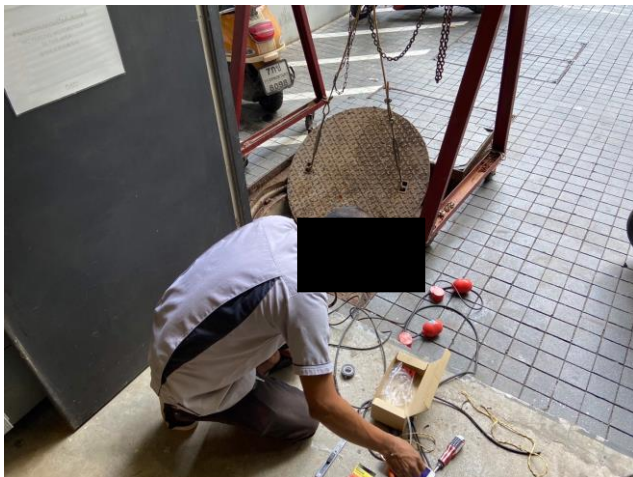
ช่างอาคารทำการเปลี่ยนลูกลอยบ่อบำบัด บั้ม SWP5-6
