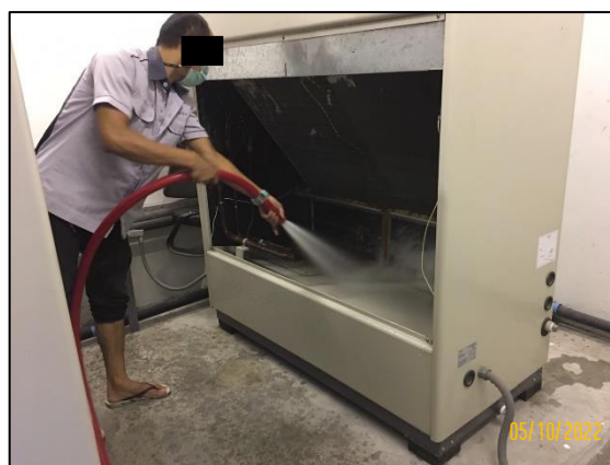
รูปที่ 2-53 การล้างเครื่องปรับอากาศ บริเวณพื้นที่ส่วนกลาง
