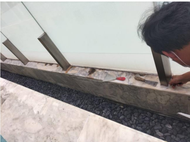
ช่างอาคารยิงซิลิโคนขอบกระจกแทนของเดิมที่หลุดร่อน บริเวณรอบสระว่ายน้ำ ชั้น 27
