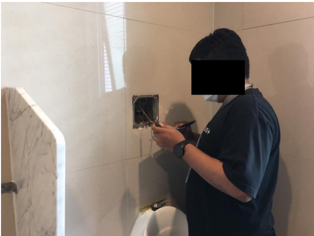
ช่างอาคารซ่อมแซมปุ่มกดน้ำโถสุขภัณฑ์ชายบริเวณพื้นที่ส่วนกลางชั้น 27 ให้กลับมาใช้งานได้ตามปกติ
