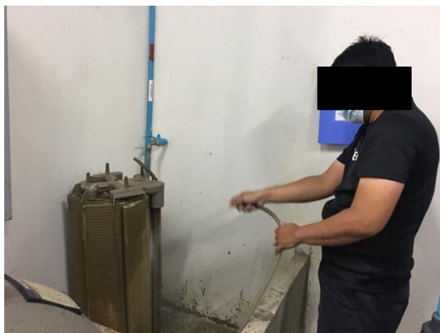
ช่างอาคารล้างทำความสะอาดไส้กรองสระเวย์น้ำกรองและบ่อพอลอย่างสม่ำเสมอทุกสัปดาห์
