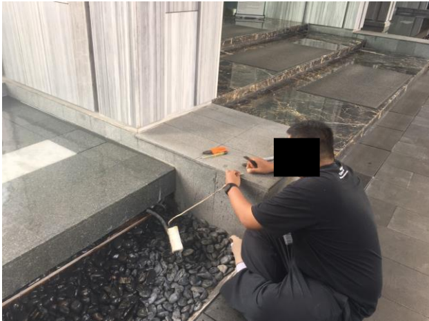
ช่างอาคารทำการเปลี่ยนหลอดไฟ LED เส้น บริเวณบ่อพอล 2
