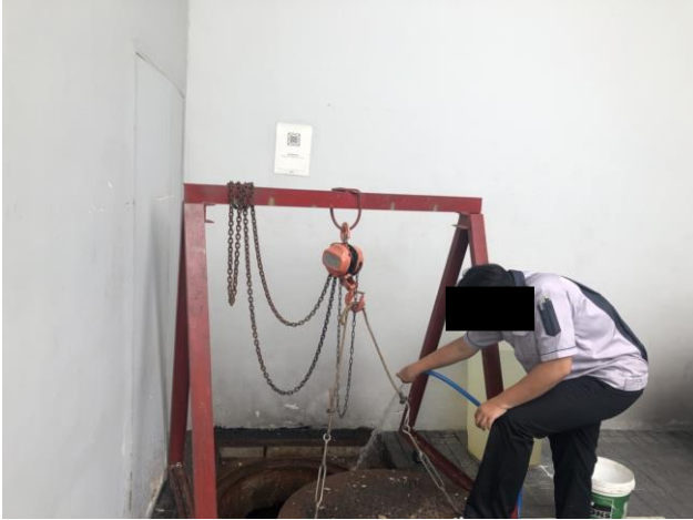
ช่างอาคารเติมหัวเชื้อจุลินทรีย์และฉีดน้ำเพื่อปรับสภาพน้ำในบ่อบำบัดน้ำเสียภายในโครงการ
