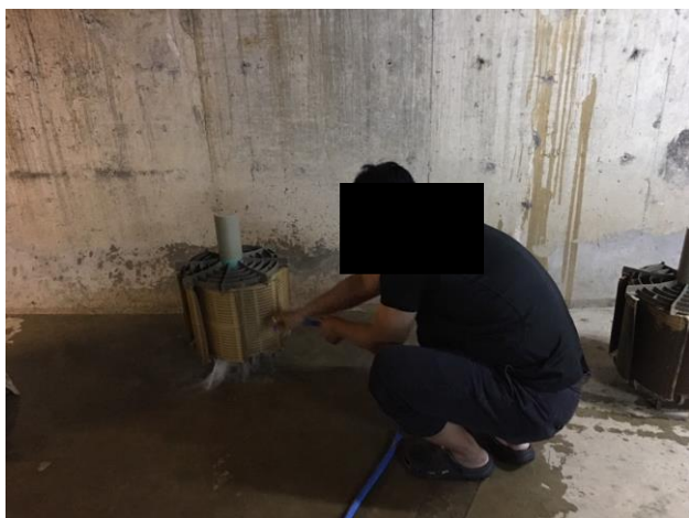
ช่างอาคารล้างทำความสะอาดไส้กรองสระเวย์น้ำกรองและบ่อพอลอย่างสม่ำเสมอทุกสัปดาห์
