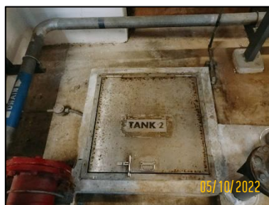
รูปที่ 2-15 ถังเก็บน้ำสำรองชั้นใต้ดินและชั้นดาดฟ้า
