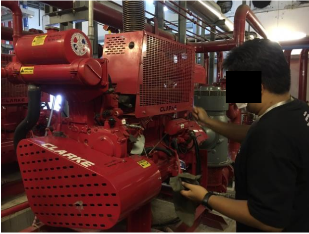
ช่างอาคารตรวจเช็คระบบการทำงาน GENERATOR, FIRE PUMP และ JOKEY PUMP อย่างสม่ำเสมอทุกสัปดาห์
