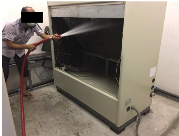
ช่างอาคารล้างทำความสะอาดAHU ของเครื่องปรับอากาศที่ติดตั้งบริเวณลิบบี้ และพื้นที่ส่วนกลางบริเวณโถงลิฟต์
