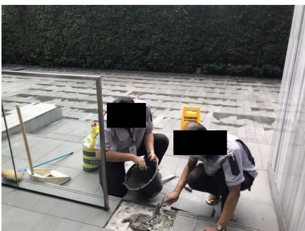
ช่างอาคารเปลี่ยนแผ่นหินแทนแผ่นเดิมที่แตกร้าวเสื่อมสภาพบริเวณบันไดทางเดินด้านหน้าลิบบี้
