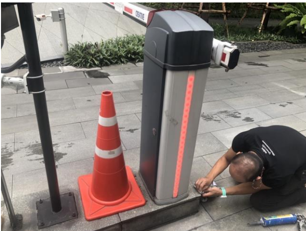
ช่างอาคารแก้ไขร่องหินด้วยการเติมยาแนว บริเวณไม้กั้นอัตโนมัติ ทางเข้า-ออก หน้าโครงการ
