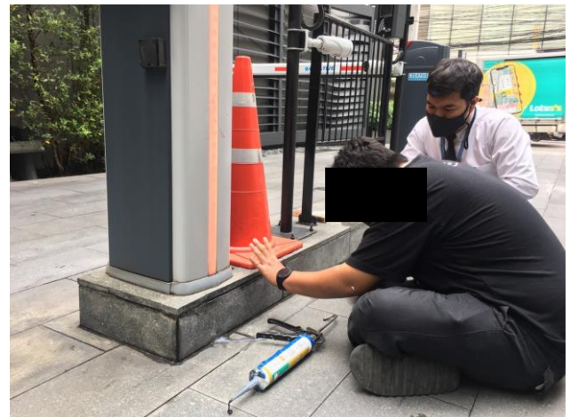
ช่างอาคารแก้ไขร่องหินด้วยการเติมยาแนว บริเวณไม้กั้นอัตโนมัติ ทางเข้า-ออก หน้าโครงการ
