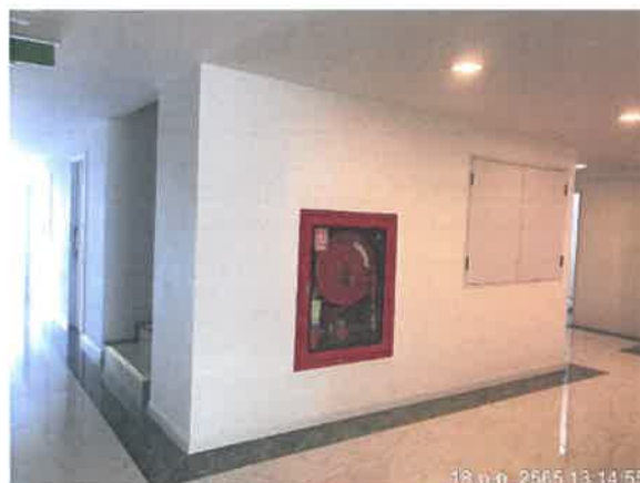
รูปที่ 2-44 แสดงตู้เก็บสายฉีดน้ำดับเพลิง (Fire Hose Cabinet) และถังดับเพลิงแบบมือถือ
