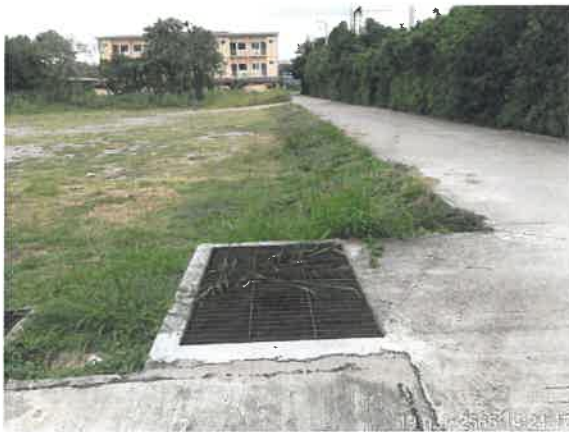
รูปที่ 2-19 แสดงบ่อพักน้ำ และตะแกรงดักมูลฝอยบริเวณจุดระบายน้ำออกจากท่อระบายน้ำของโครงการ
