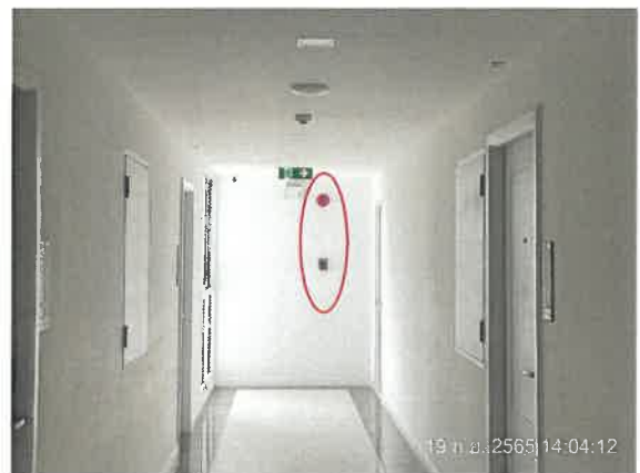
รูปที่ 2-46 แสดงกริ่งสัญญาณเตือนภัย (Alarm Bell) และเครื่องแจ้งเหตุโดยใช้มือกด (Fire Manual Station Unit)
