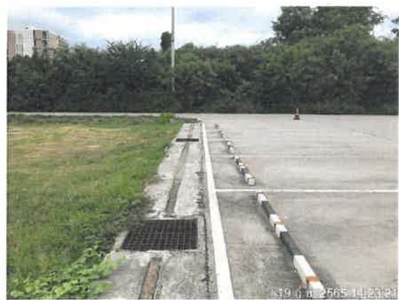
รูปที่ 2-19 แสดงบ่อพักน้ำ และตะแกรงดักมูลฝอยบริเวณจุดระบายน้ำออกจากท่อระบายน้ำของโครงการ
