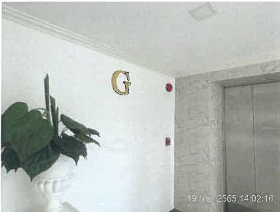
รูปที่ 2-46 แสดงกริ่งสัญญาณเตือนภัย (Alarm Bell) และเครื่องแจ้งเหตุโดยใช้มือกด (Fire Manual Station Unit)
