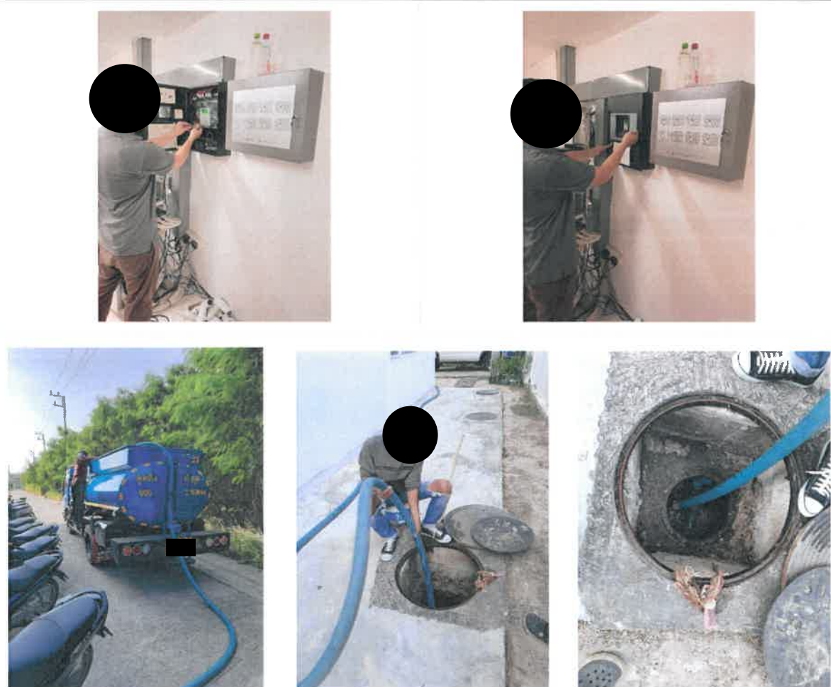
รูปที่ 2-17 แสดงช่างประจำโครงการดูแลระบบบำบัดน้ำเสีย และจัดเจ้าหน้าที่ดำเนินการสูบน้ำเสียจากส่วนเกินจากระบบบำบัดน้ำเสียไปกำจัด
