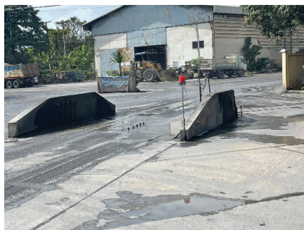
รูปที่ 2-37: บ่อล้างล้อรถบรรทุก
