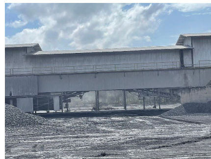
รูปที่ 2-30: การปิดคลุมอาคารโรงโม่หิน
