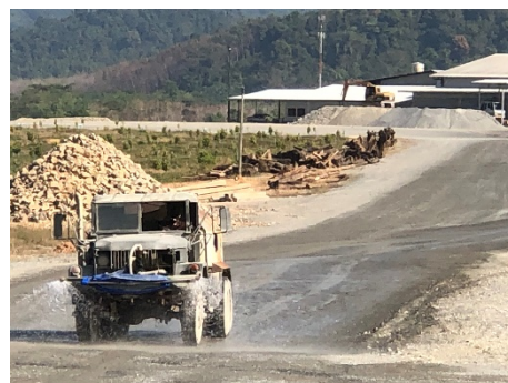
รูปที่ 2-26: การฉีดพรมน้ำบริเวณเส้นทางขนส่งแร่
