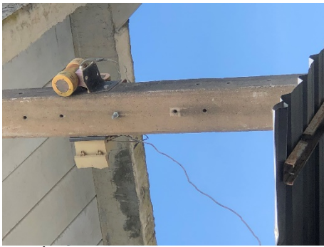
รูปที่ 2-9: สัญญาณเตือนก่อนการระเบิด
