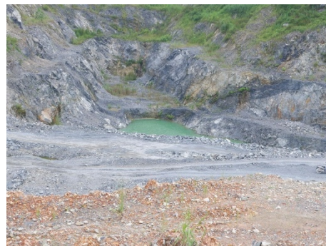
รูปที่ 2-8: บ่อรับน้ำ (Sump)
