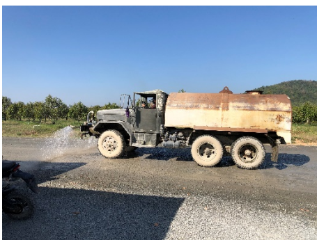
รูปที่ 2-26: การฉีดพรมน้ำบริเวณเส้นทางขนส่งแร่
