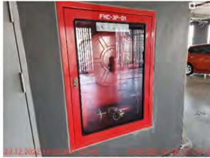
ภาพที่ 2-58 ตู้เก็บสายฉีดน้ำดับเพลิง พร้อมอุปกรณ์
