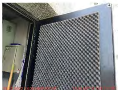
ภาพที่ 2-87 แผ่นดูดซับเสียงห้องเครื่อง สูบน้ำของสระว่ายน้ำ
