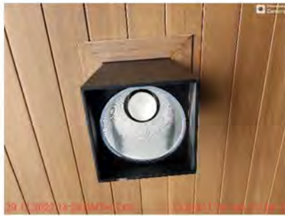
ภาพที่ 2-48 หลอดไฟประหยัดพลังงาน แบบ Light Emitting Diode (LED)
