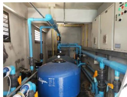
ภาพที่ 3-12 ระบบกรองน้ำสระว่ายน้ำ อยู่ในสภาพดีไม่ชำรุด
