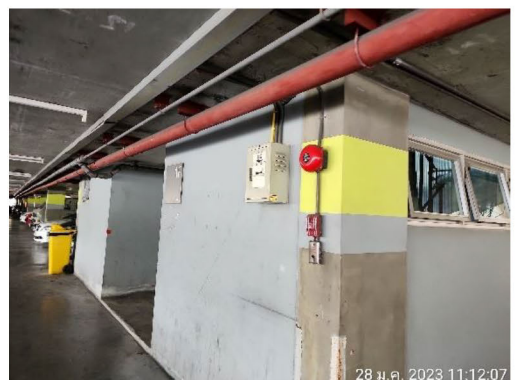
ภาพที่ 2-56 อุปกรณ์แจ้งเหตุสัญญาณเตือนเพลิงไหม้ในอาคาร
