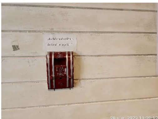
ภาพที่ 2-56 อุปกรณ์แจ้งเหตุสัญญาณเตือนเพลิงไหม้ในอาคาร
