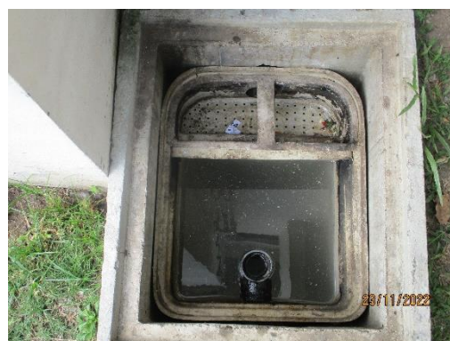
รูปที่ 2-11 ถังดักไขมัน บริเวณด่านเก็บค่าผ่านทางตลิ่งชัน
