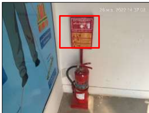
ภาพที่ 38 ป้ายแนะนำการใช้อุปกรณ์ดับเพลิง
