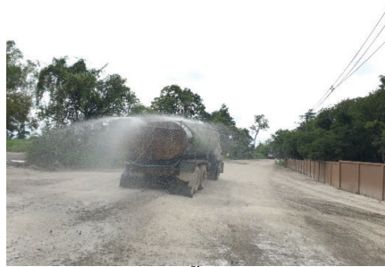
รูปที่ 2-17: การฉีดพรมน้ำบริเวณเส้นทางขนส่งแร่
