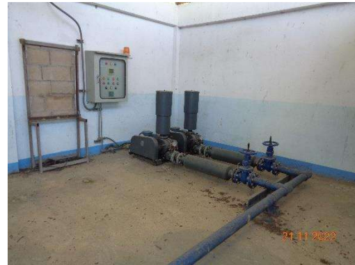
รูปที่ 3-1 ปั่นเติมอากาศสำหรับระบบบำบัดน้ำเสีย
