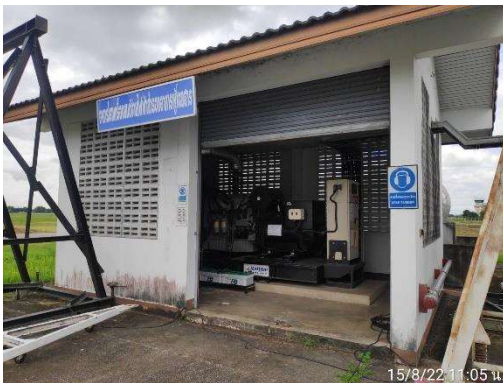
รูปที่ 3-2 เครื่องสำรองไฟฟ้าสำหรับอาคารผู้โดยสาร และระบบบำบัดน้ำเสีย
