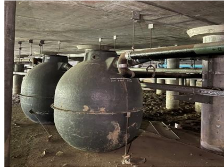
ภาพที่ 2.2-11 ระบบบำบัดน้ำเสียบริเวณศูนย์ซ่อมบำรุง
