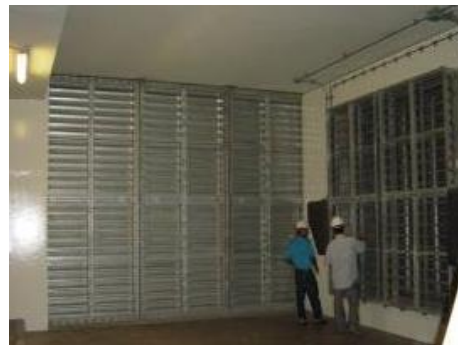
ภาพที่ 2.2-6 ปล่องระบายอากาศจากใต้ชั้นขานซาลาสู่ภายนอก
