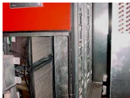
ภาพที่ 2.2-3 การติดตั้งแผ่นกรองอากาศด้านข้างเครื่องส่งลมเย็น
