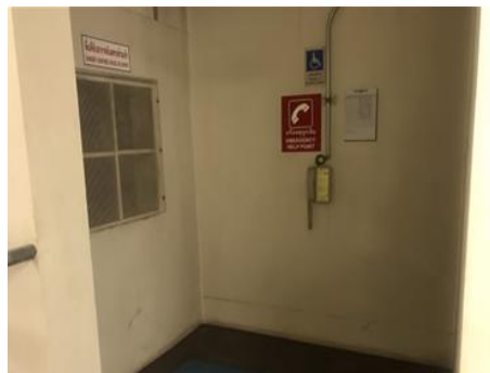
ภาพที่ 2.2-29 จุดรอความช่วยเหลือและโทรศัพท์ฉุกเฉินสำหรับผู้พิการในทางหนีไฟ
