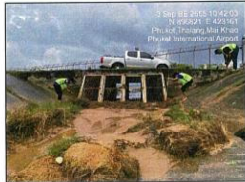
ภาพถ่ายที่ 3.3-17 การขุดลอกระบบระบายน้ำในท่าอากาศยาน
