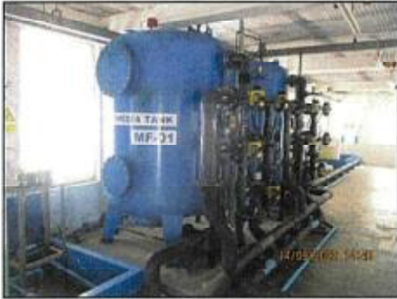
ภาพถ่ายที่ 2.3.3-1 ถังกรองแบบปิดทรงกระบอกแนวตั้ง (Vertical Pressure Filter)
