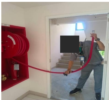
รูปที่ 2-28 การตรวจเช็คอุปกรณ์ป้องกันอัคคีภัย
