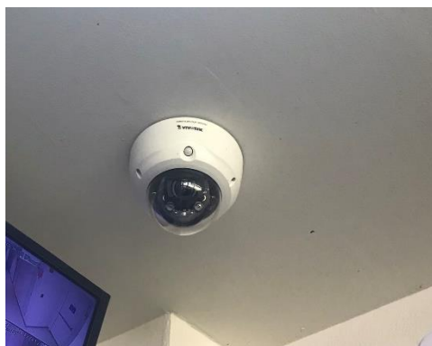
รูปที่ 2-34 ระบบโทรทัศน์วงจรปิด (CCTV System)
