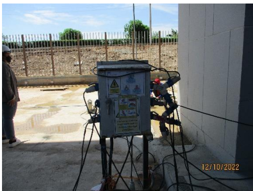
รูปที่ 30 หม้อแปลงไฟฟ้าของโครงการและตู้ไฟฟ้าชั่วคราว
