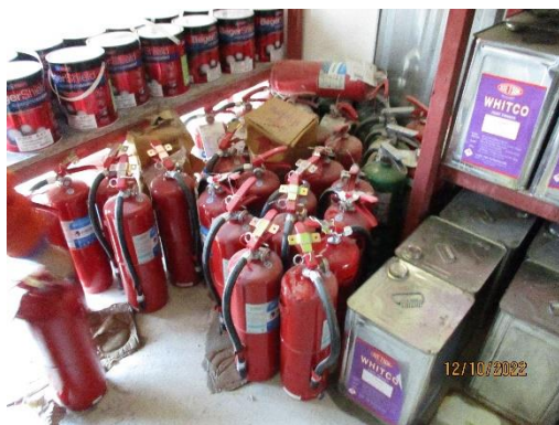
รูปที่ 27 ถังดับเพลิง และป้ายการตรวจสอบการใช้งาน
