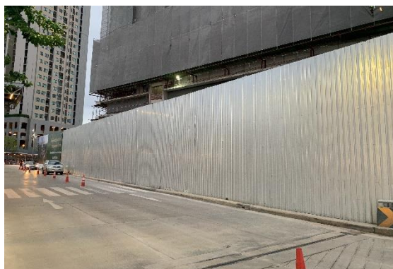
รูปที่ 1 รั้วชั่วคราว Metal Sheet สูง 6 เมตร และกำแพงคอนกรีตถาวร
