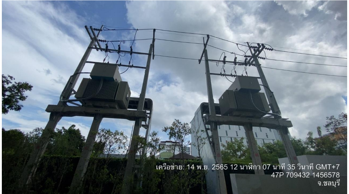
รูปที่ 50 หม้อแปลงไฟฟ้า
