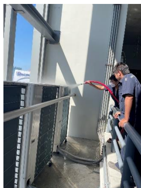
รูปที่ 3 เจ้าหน้าที่ทำความสะอาดเครื่องปรับอากาศ
