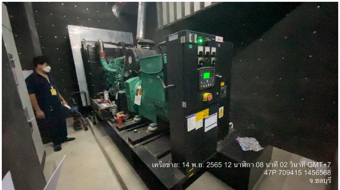
รูปที่ 51 เครื่องกำเนิดไฟฟ้าฉุกเฉิน
