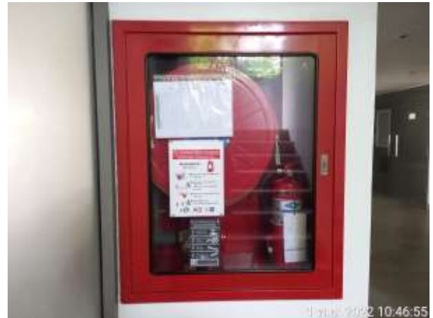
รูปที่ 2.14 ชุดตู้ดับเพลิง (FHC)
