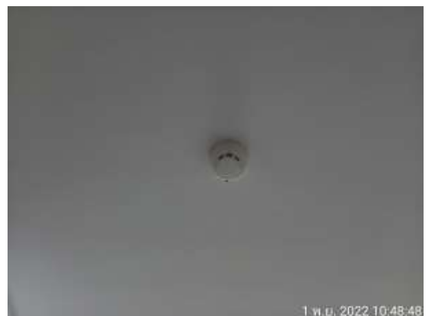
รูปที่ 2.16 เครื่องดักจับควัน
