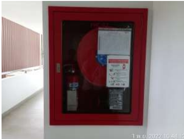
รูปที่ 2.14 ชุดตู้ดับเพลิง (FHC)
