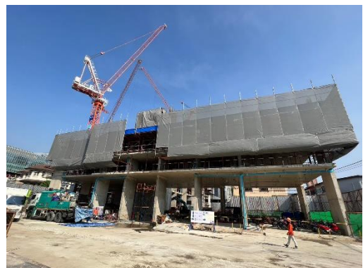
รูปที่ 73 ติดตั้งผ้าใบก่อสร้าง (Mesh Sheet ชนิดกันไฟลาม) คลุมรอบตัวอาคาร
