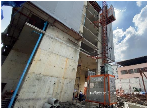
รูปที่ 79 ลิฟต์ขนส่งวัสดุก่อสร้าง
