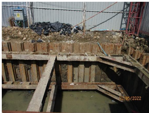
รูปที่ 20 ติดตั้ง ระบบค้ำยันและระบบป้องกันดินพังด้วย Sheet Pile
