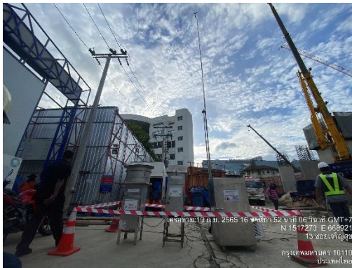
รูปที่ 24 ติดตั้งเครื่องมือตรวจวัดคุณภาพสิ่งแวดล้อม (คุณภาพอากาศ ระดับเสียง ความสั่นสะเทือน)
