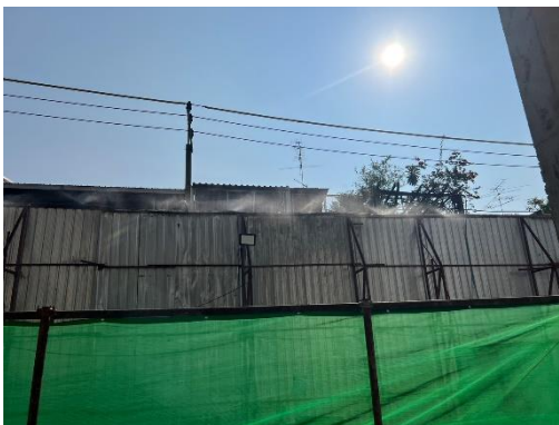
รูปที่ 25 สเปรย์พ่นน้ำอัตโนมัติ
