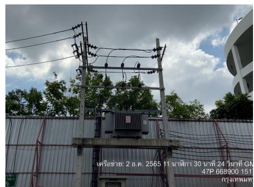
รูปที่ 65 หม้อแปลงไฟฟ้า
