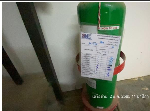
รูปที่ 81 ตรวจสอบสภาพการใช้งานของถังดับเพลิง
