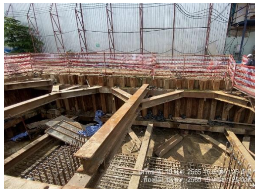
รูปที่ 20 ติดตั้ง ระบบค้ำยันและระบบป้องกันดินพังด้วย Sheet Pile
