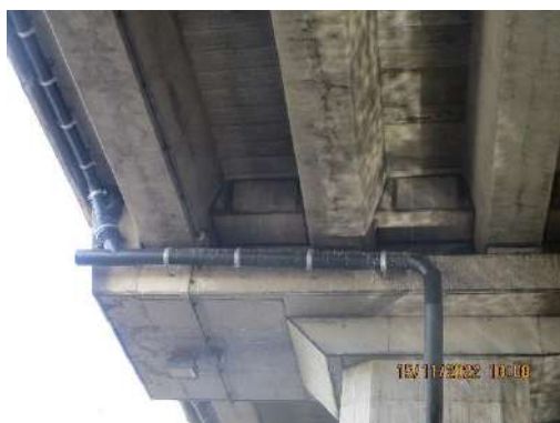
รูปที่ 2-5 ท่อระบายน้ำตลอดแนวเส้นโครงการ
