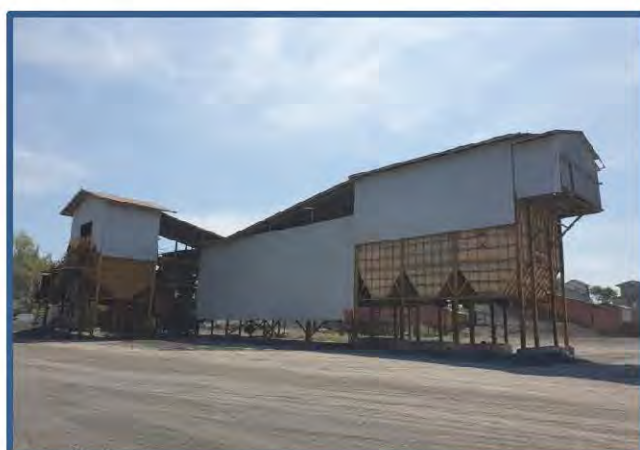
รูปที่ 2-10 การปิดปกคลุมสายพานลำเลียง
