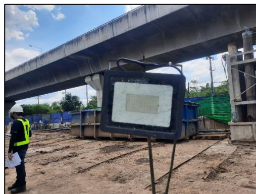
รูปที่ 2-29 การติดตั้งไฟส่องสว่าง ภายในพื้นที่ก่อสร้าง
