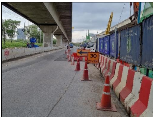
รูปที่ 2-33 การตีช่องจราจร และการจัดระยะสอบ
