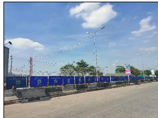
รูปที่ 2-12 การกั้นกำแพงคอนกรีต พร้อมรั้วผ้าใบทึบ ความสูง 2.0 เมตร
