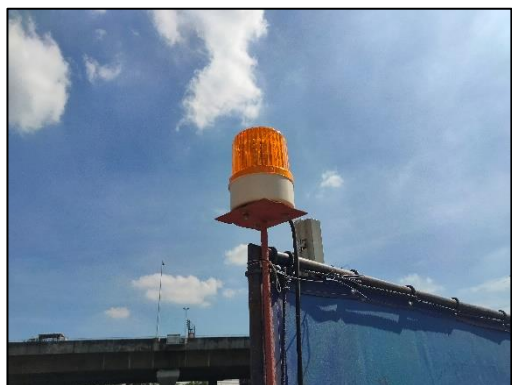
รูปที่ 2-28 การติดตั้งไฟกะพริบ
