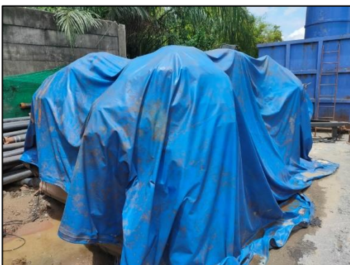
รูปที่ 2-17 การใช้ผ้าใบปิดคลุมกองดิน/กองเศษวัสดุ
