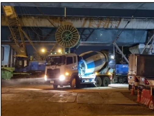
รูปที่ 2-13 การใช้คอนกรีตผสมเสร็จ
