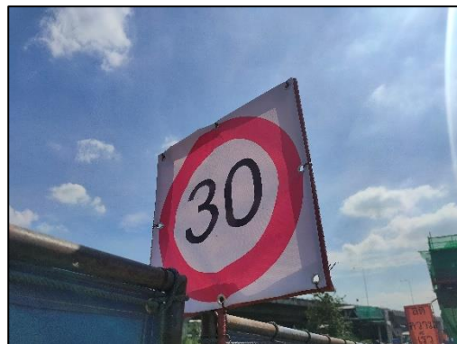
รูปที่ 2-16 การติดตั้งป้ายควบคุมความเร็ว 30 กิโลเมตร/ชั่วโมง
