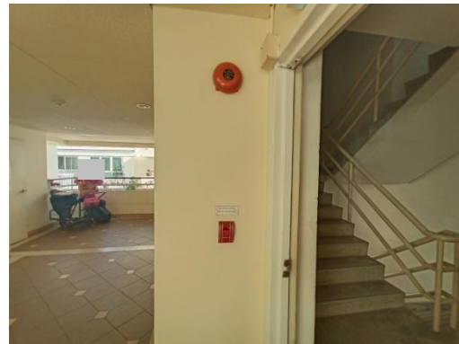
รูปที่ 2-18 สัญญาณแจ้งเตือนแบบกริ่ง และอุปกรณ์แจ้งเตือนเหตุแบบมือดึง
