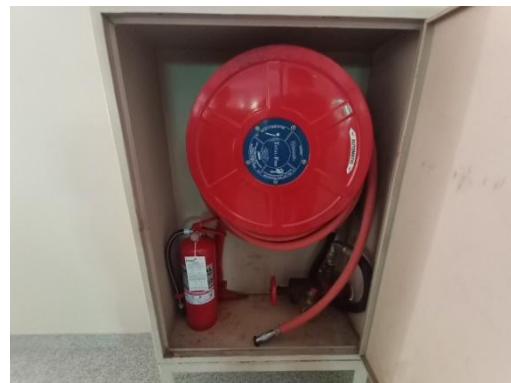
รูปที่ 2-20 ตู้เก็บสายดับเพลิงและถังดับเพลิง
