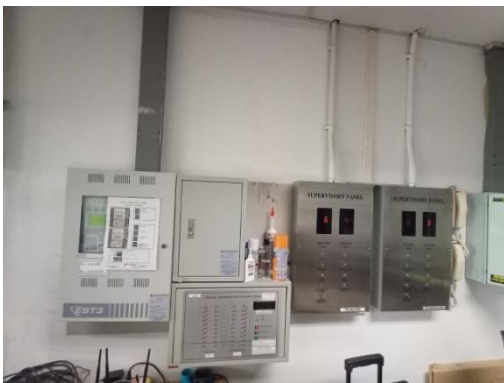
รูปที่ 2-39 แผงควบคุมระบบแจ้งเหตุอัคคีภัย
