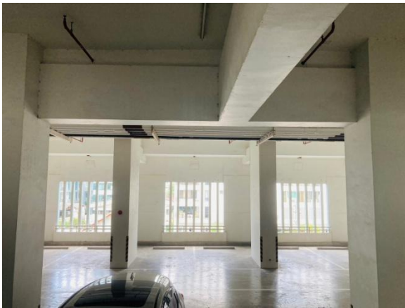
รูปที่ 2-65 มีการออกแบบให้ชั้นลานจอดรถ สามารถระบายอากาศได้
