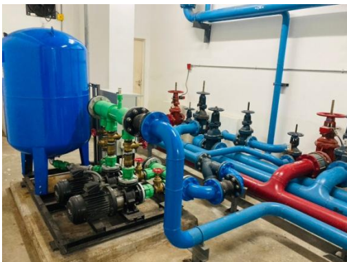
รูปที่ 2-59 ห้องเครื่องสูบน้ำ
