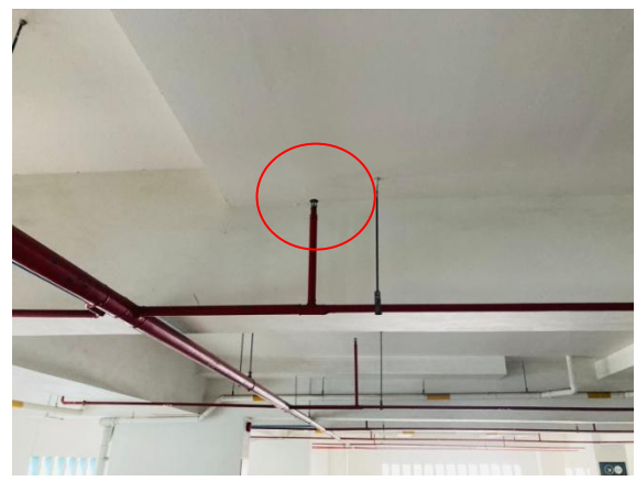
รูปที่ 2-24 หัวกระจายน้ำดับเพลิงอัตโนมัติ (Sprinkler)
