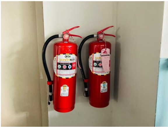
รูปที่ 2-23 ถังดับเพลิงชนิดมือถือ
