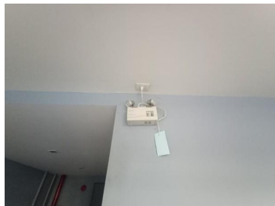
รูปที่ 2-9 เครื่องสำรองไฟ
