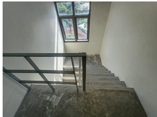
รูปที่ 2-55 ช่องระบายอากาศบริเวณบันไดหนีไฟ
