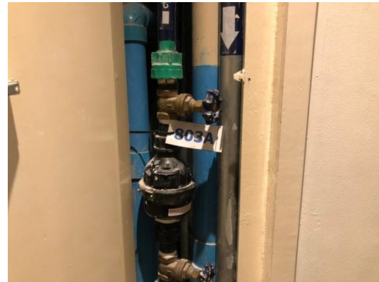
รูปที่ 2-27 มิเตอร์น้ำประปาแต่ละชั้น
