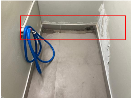
รูปที่ 2-19 ท่อรวบรวมน้ำทิ้งจากห้องพักขยะประจำชั้น
