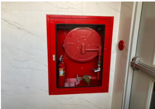
ตู้เก็บสายฉีดน้ำดับเพลิง
