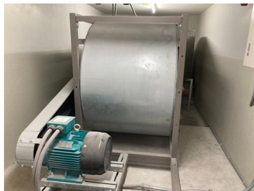
รูปที่ 2-34 พัดลมระบายอากาศ
