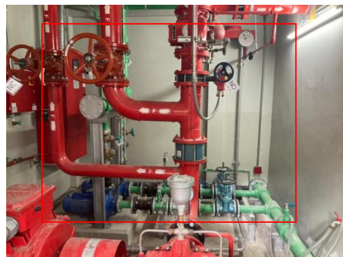
รูปที่ 2-17 ป้อนน้ำใช้ชั้นใต้ดิน
