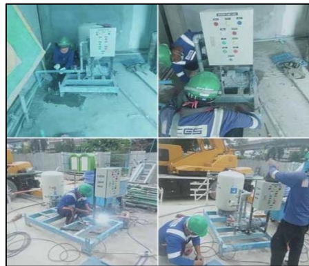
รูปที่ 1-3 การรื้อถอนระบบบำบัดน้ำเสียสำเร็จรูปชั่วคราว
