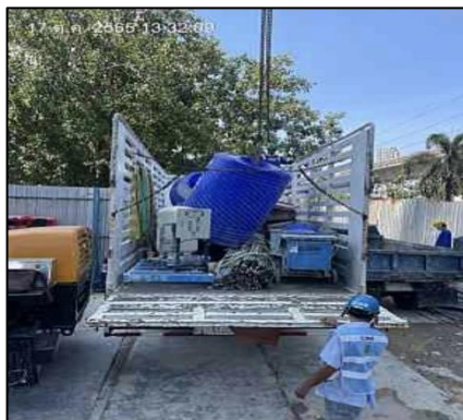
รูปที่ 1-3 การรื้อถอนระบบบำบัดน้ำเสียสำเร็จรูปชั่วคราว
