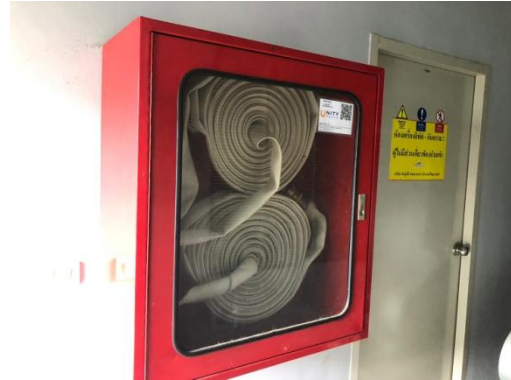
รูปที่ 2-25 ตู้เก็บสายดับเพลิง
