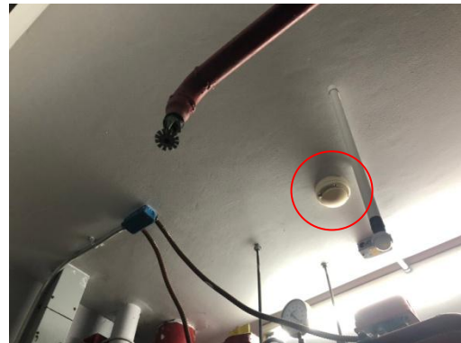
รูปที่ 2-20 เครื่องดักจับควัน
