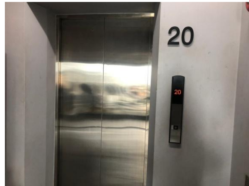
รูปที่ 2-27 ลิฟต์ดับเพลิง
