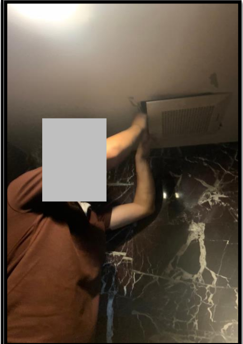
ช่างอาคารทำการเปลี่ยนพัดลมดูด อากาศบริเวณหน้าลิฟต์โดยสาร ส่วนกลางของอาคารชุดฯ ทดแทน ของเดิมที่เสื่อมสภาพ
