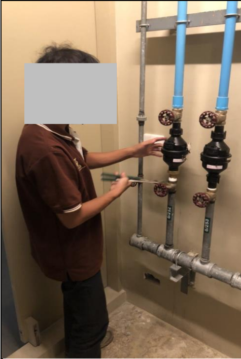
ช่างอาคารทำการซ่อมแก้ไขการรั่วซึม ของท่อต่อมิเตอร์น้ำประปา บริเวณห้อง ซาร์ปน้ำของอาคารชุด
