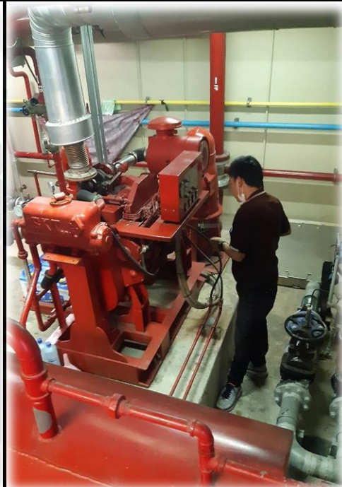
ช่างอาคารทำการตรวจเช็คและ ทดสอบระบบเครื่องสูบน้ำดับเพลิงของ อาคารชุดฯ
