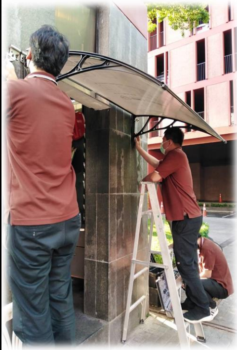
ติดตั้งกันสาดบังแดดทดแทนของเดิมที่ ชำรุด บริเวณป้อมรักษาความปลอดภัย ด้านหน้าโครงการ
