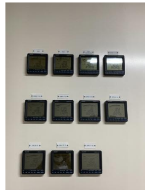
รูปที่ 2-13 ติดตั้งมิเตอร์ไฟฟ้าสำหรับระบบบำบัดน้ำเสีย
