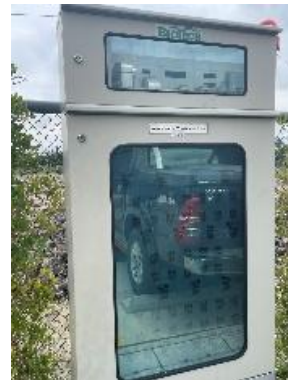
รูปที่ 2-11 ตู้ควบคุมการทำงานของระบบบำบัดน้ำเสีย
