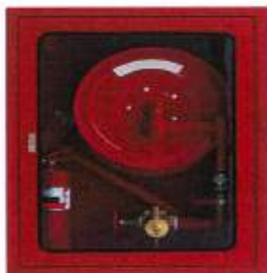
ภาพหัวจ่ายน้ำดับเพลิง อุปกรณ์ดับเพลิง และตู้ดับเพลิง
