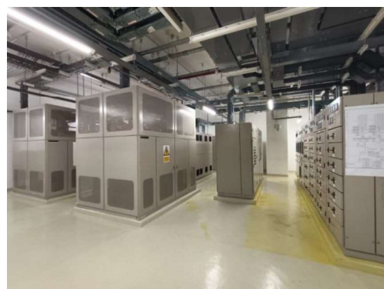
รูปที่ 3-18 หม้อแปลงไฟฟ้า ส่วนสำนักงาน
