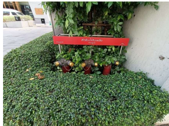
รูปที่ 3-26 ติดตั้งหัวรับน้ำดับเพลิง ของส่วนสำนักงาน และส่วนโรงแรม ทางทิศตะวันตกของโครงการ
