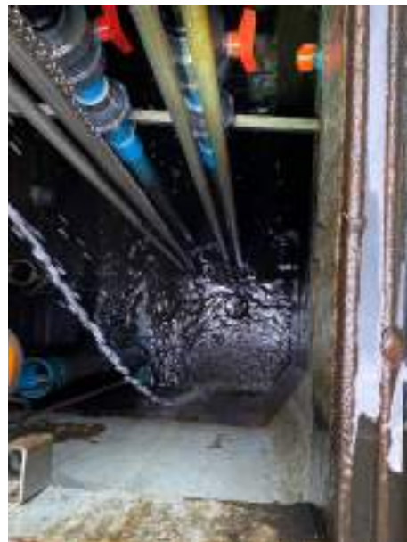
ตะกอนสะสมภายในบ่อน้ำทิ้งเพื่อ REUSE
