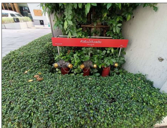
รูปที่ 2-9 หัวรับน้ำดับเพลิง ส่วนสำนักงาน และส่วนของโรงแรม
