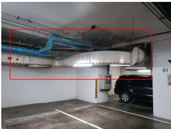
รูปที่ 3-3 ติดตั้งพัดลมบริเวณลานจอดรถชั้นใต้ดิน
