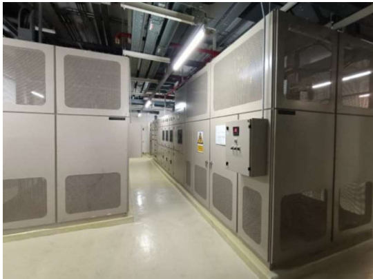
รูปที่ 3-19 หม้อแปลงไฟฟ้า ส่วนโรงแรม
