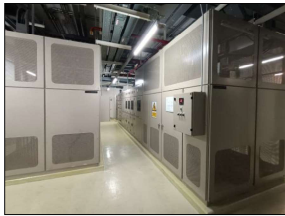
รูปที่ 2-8 หม้อแปลงไฟฟ้า ส่วนโรงแรม
