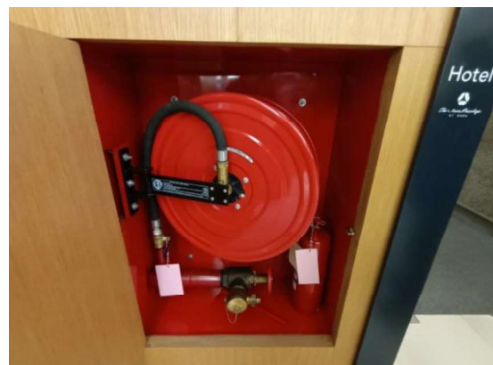
รูปที่ 3-30 ตู้เก็บสายฉีดน้ำดับเพลิง
