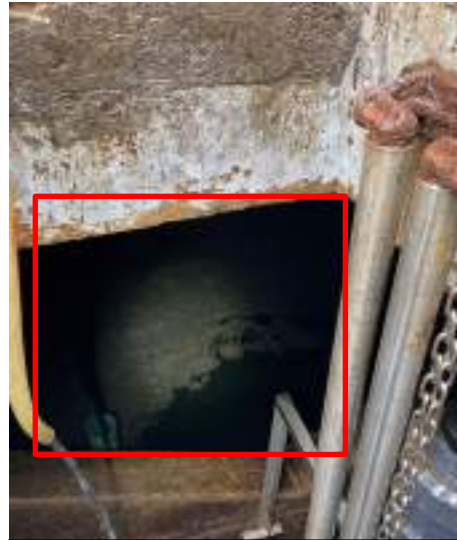
ตะกอนสะสมภายในบ่อน้ำทิ้งเพื่อ REUSE
