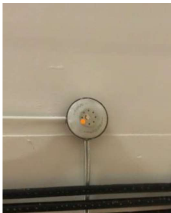
รูปที่ 3-39 เครื่องตรวจจับความร้อน
