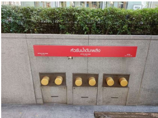
รูปที่ 3-27 ติดตั้งหัวรับน้ำดับเพลิง ของส่วนสำนักงาน และส่วนโรงแรม ทางทิศเหนือของโครงการ
