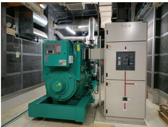
รูปที่ 3-21 เครื่องกำเนิดไฟฟ้าฉุกเฉิน ส่วนโรงแรม
