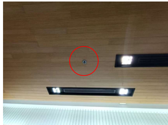
รูปที่ 3-32 ระบบหัวจ่ายน้ำดับเพลิงอัตโนมัติ
