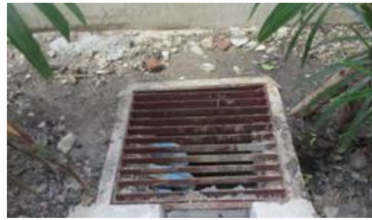
รูปที่ 15 ตะแกรงดักขยะ
