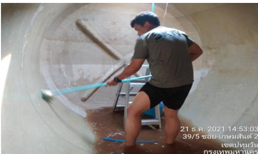
รูปที่ 47 ทำความสะอาดถังเก็บน้ำชั้นดาดฟ้า และชั้นใต้ดิน
