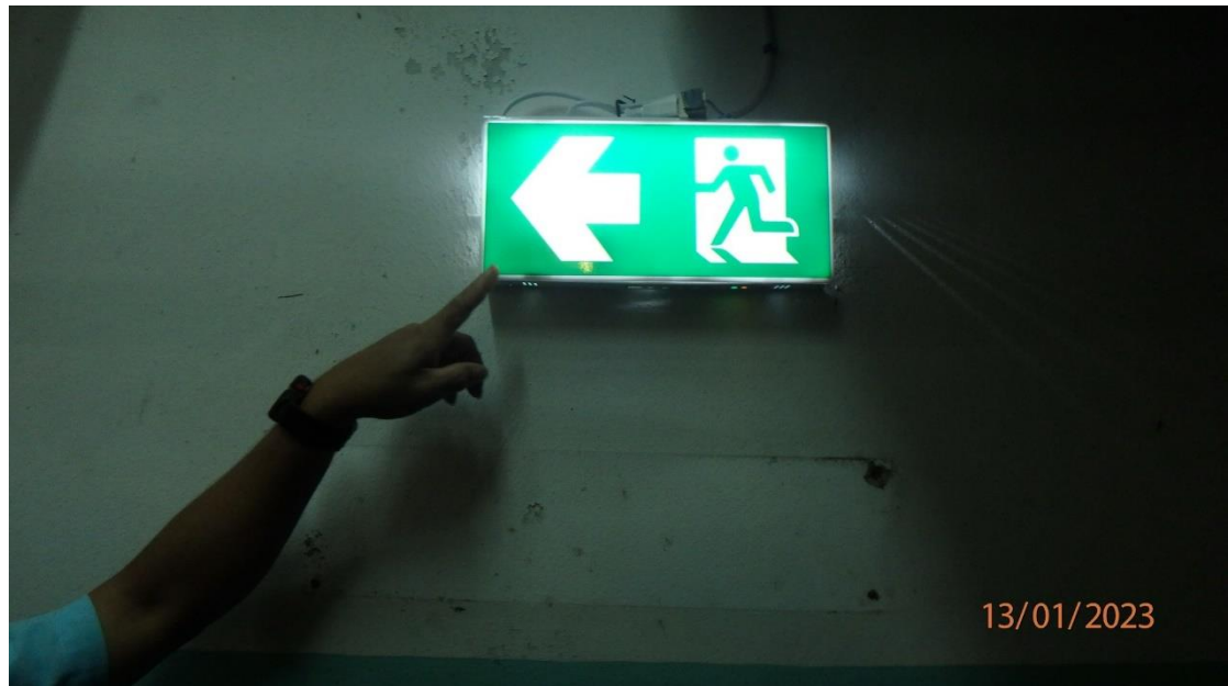
รูปที่ 2-9 การสุ่มตรวจสอบการทำงานของป้ายแสดงทางหนีไฟ บริเวณทางออกหน้าห้องสไตร์ช่าง
