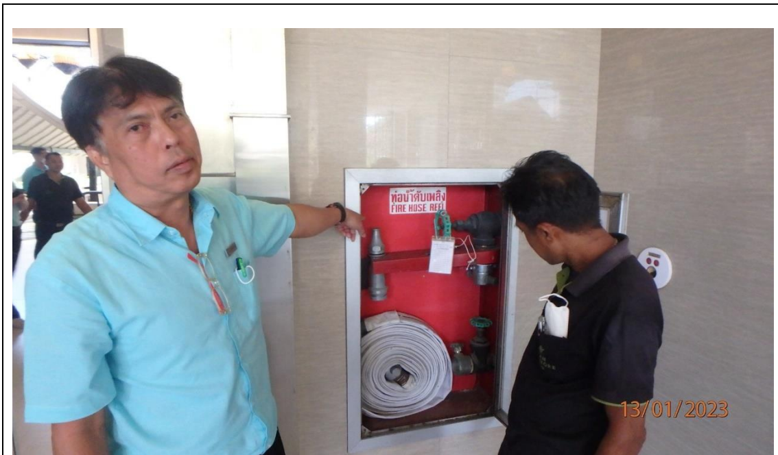
รูปที่ 2-5 การสุ่มตรวจสอบความพร้อมของตู้สายฉีดน้ำดับเพลิง บริเวณล็อบบี้
