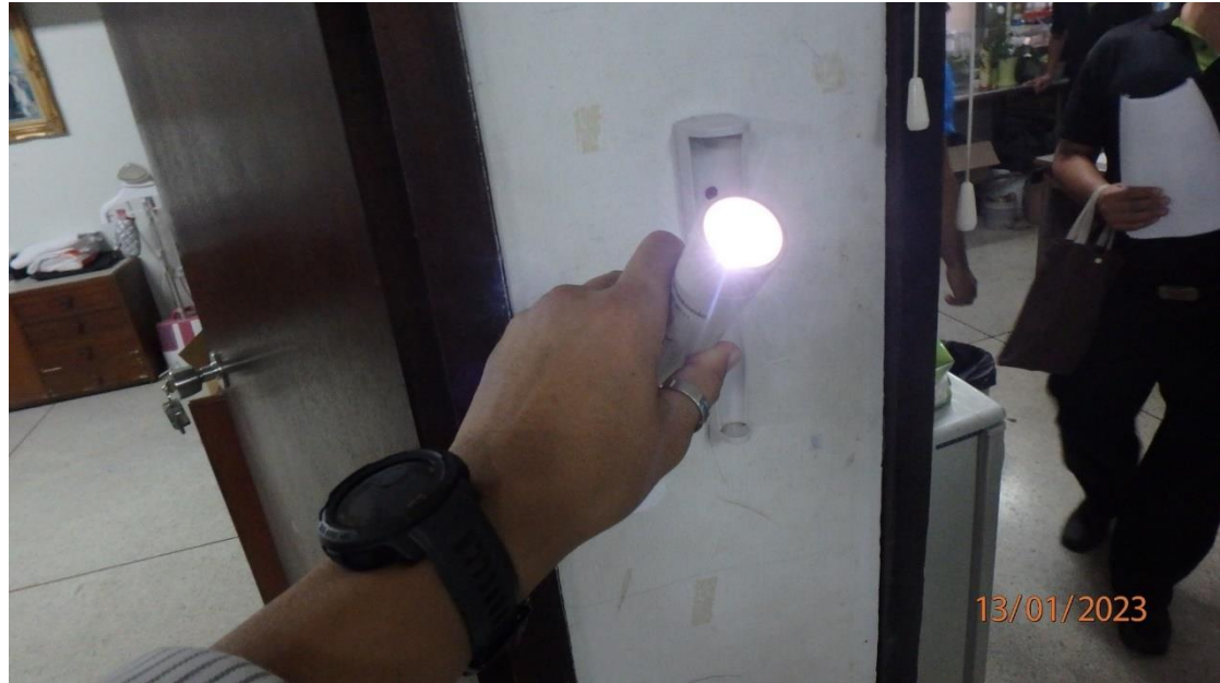
รูปที่ 2-8 การสุ่มตรวจสอบการทำงานของไฟฉายฉุกเฉิน บริเวณแผนกแม่บ้าน
