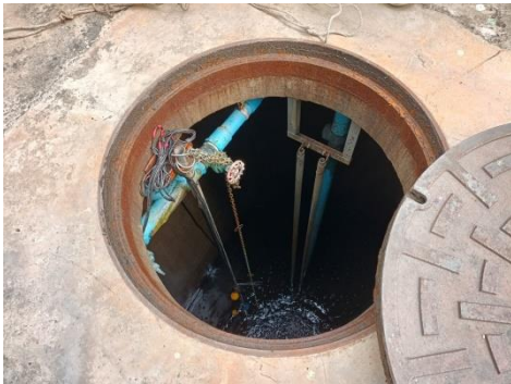
บ่อบำบัดน้ำเสียก่อนเข้าสู่ระบบ
