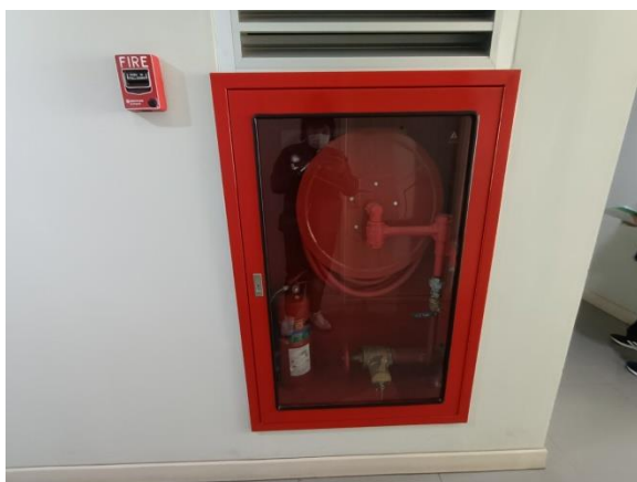
รูปที่ 2-21 ตู้เก็บสายฉีดน้ำดับเพลิง
