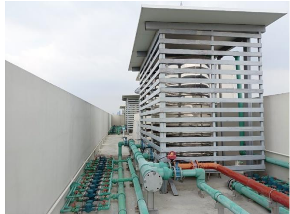
รูปที่ 2-18 ถังสำรองน้ำใช้ชั้นดาดฟ้า
