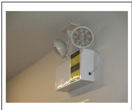
รูปที่ 2.3-21 ไฟส่องสว่างฉุกเฉิน
