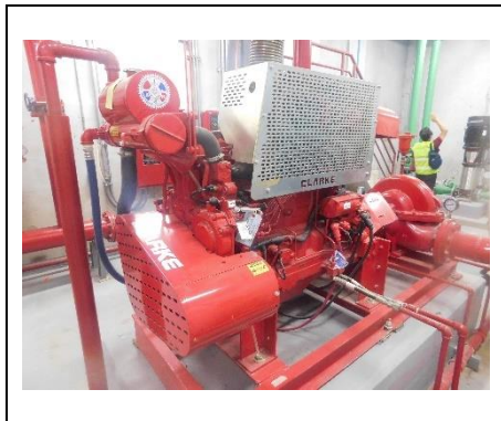
รูปที่ 2.3-25 เครื่องสูบน้ำดับเพลิง
