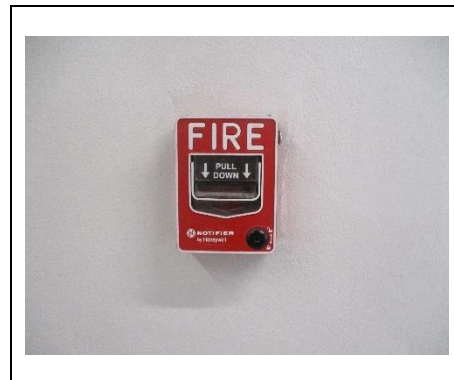
รูปที่ 2.3-28 อุปกรณ์แจ้งเหตุด้วยมือ
