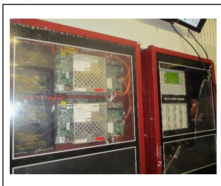
รูปที่ 2.3-29 ตู้ควบคุมแจ้งเหตุเพลิงไหม้
