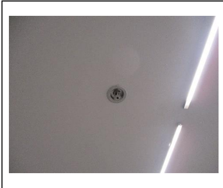
รูปที่ 2.3-33 หัวกระจายน้ำอัตโนมัติ
