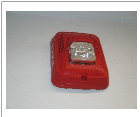
รูปที่ 2.3-27 อุปกรณ์ส่งสัญญาณเสียง
