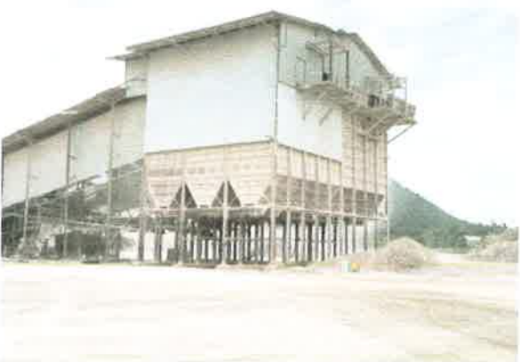
รูปที่ 15 การปิดคลุมอาคารโรงโม่หินชุด Product Screen
