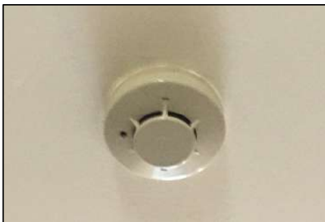
ภาพที่ 1-10 อุปกรณ์ตรวจจับควันและความร้อน (Smoke and Heat Detector)
