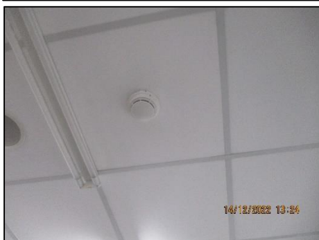
รูปที่ 2-6 อุปกรณ์ป้องกันและเตือนอัคคีภัย
