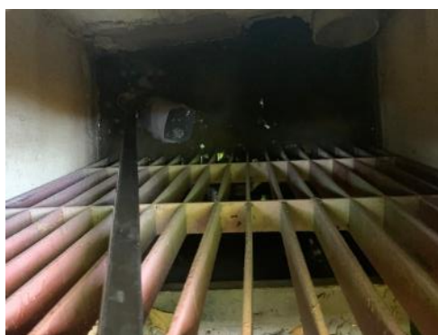
รูปที่ 3.33 ภาพแสดงการเก็บตัวอย่างน้ำจุดที่ 5 คุณภาพน้ำก่อนระบายออกสู่ภายนอกโครงการ บ่อดักขยะ
