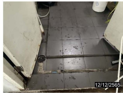
ภาพที่ 2-52 ท่อรวบรวมน้ำจากการล้าง ห้องพักมูลฝอย
