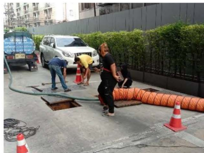
ภาพที่ 2-11 การสูบน้ำที่ระบบบำบัดน้ำเสีย
