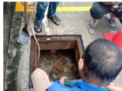
ภาพที่ 2-11 การสูบน้ำที่ระบบบำบัดน้ำเสีย
