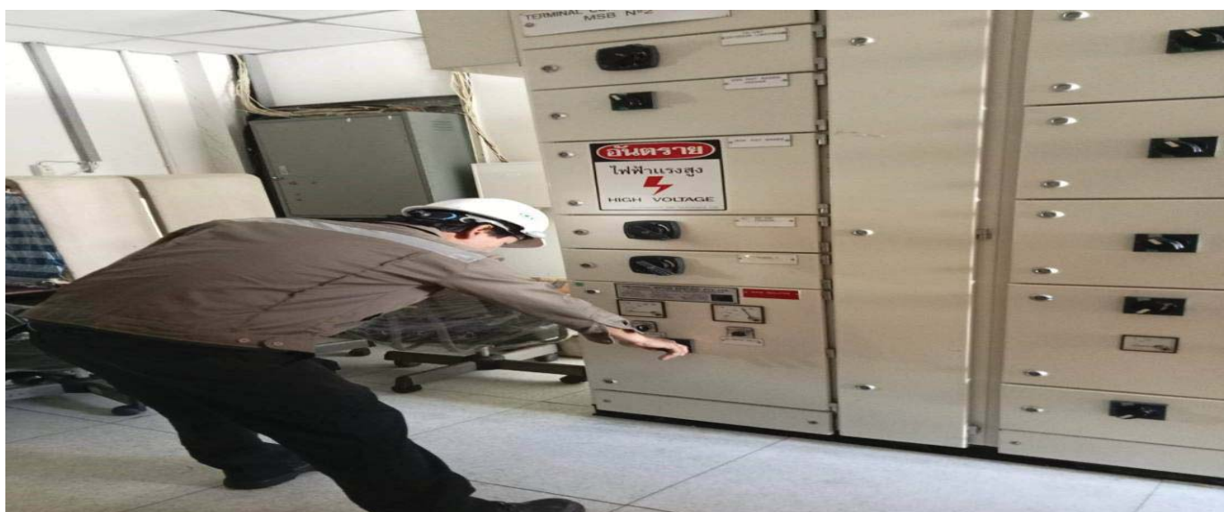
STT 8 หัวหน้าซ่อมบำรุง ปิดระบบจ่ายไฟฟ้าบริเวณอาคารโรงซ่อม อาคาร 1 และจุด LOW POINT
