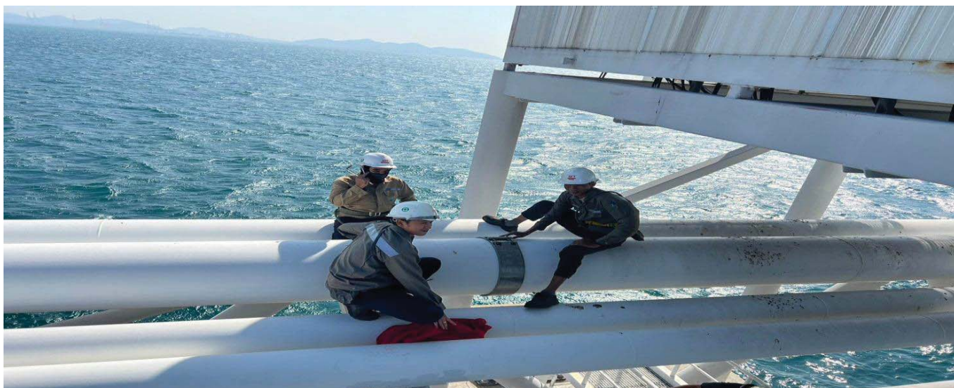
STT 12 พนักงานซ่อมบำรุงนำ CAMP รัศมี 24 นิ้วเสร็จหยุดการรั่วไหลของน้ำมัน
