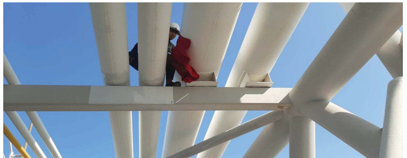
STT 5 พนักงาน OPERATION ประจำ ทำ 2 นำผ้าไปอุดรูรั่วท่อตามคำสั่ง เพื่อให้ปริมาณน้ำมันที่รั่วไหลลงทะเลให้น้อย
