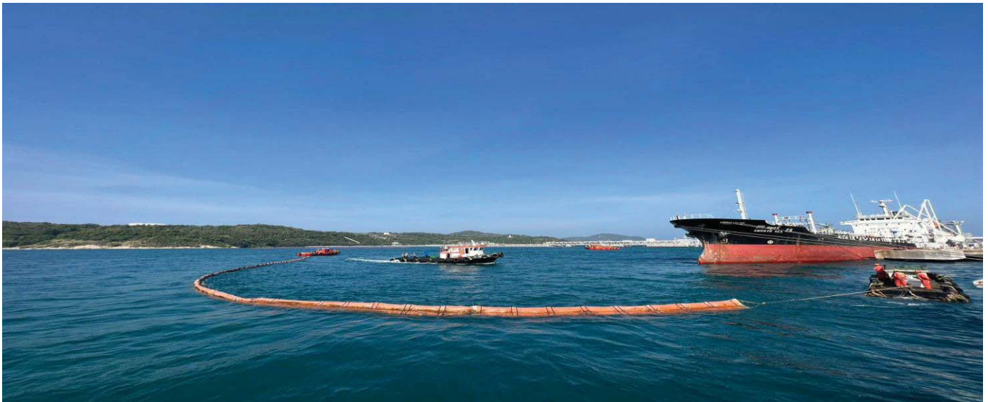
STT 10 เรือทัก ACS 2 นำทีมขจัดคราบน้ำมันเข้าทำการเก็บคราบน้ำมัน ใน BOOM
