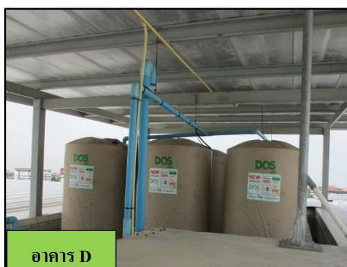
รูปที่ 1-4 ถังเก็บน้ำชั้นดาดฟ้า
